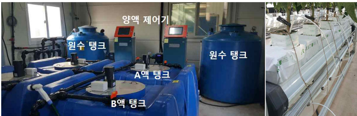
그림 2-1-4. 파프리카 양액 제어기 및 공급 장치
