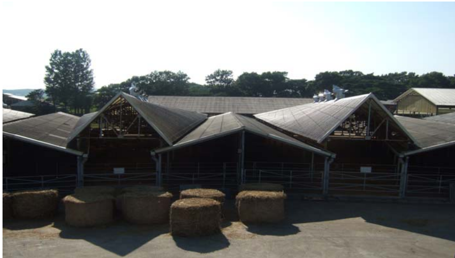
<그림 4-3> 변식우사의 지붕 추가 설치 모습
