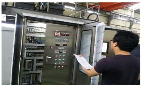
Fig. 178 펌프일체형수문 시스템의 배수펌프 시운전
