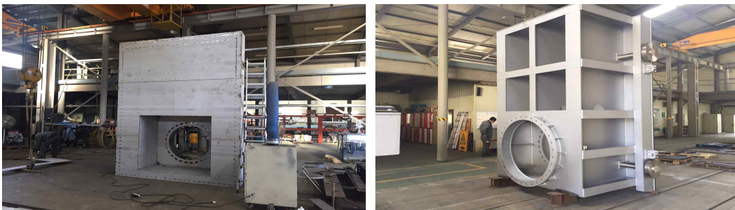
Fig. 37 펌프일체형수문 시스템의 수문구조물 제작 및 조립
