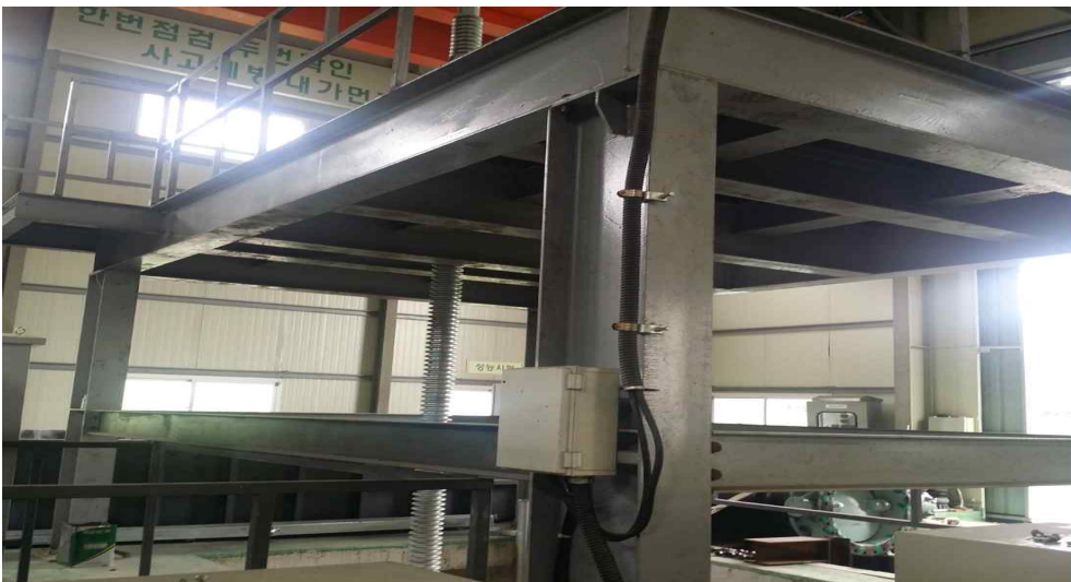
Fig. 166 개폐기 프레임 설치
