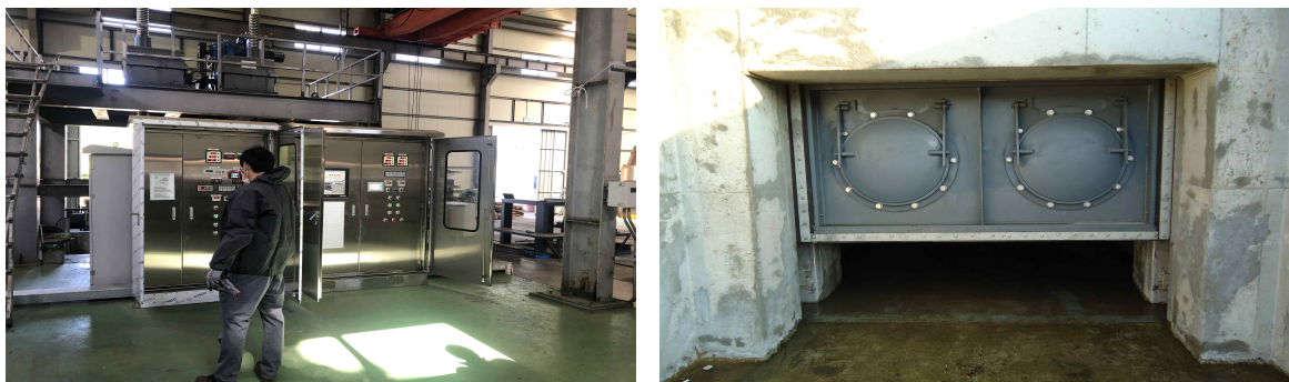
Fig. 182 펌프일체형수문 시스템 통합 및 조립
