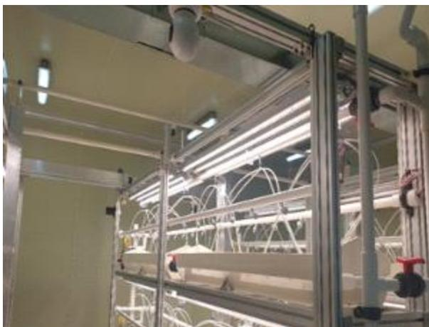
그림 32. LED 인공광 점등 테스트
