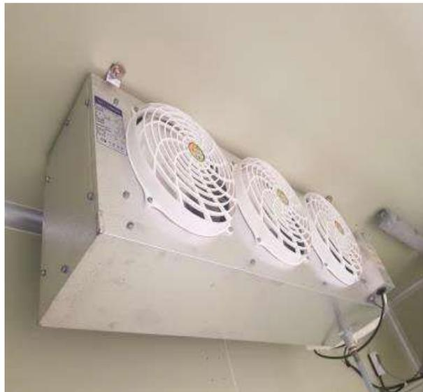
그림 43. 유니트 쿨러 설치
