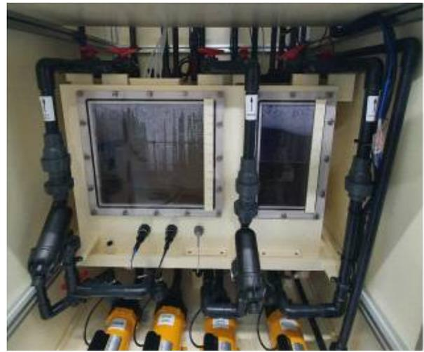
그림 16. 양액 및 약제 관리/공급 시스템
