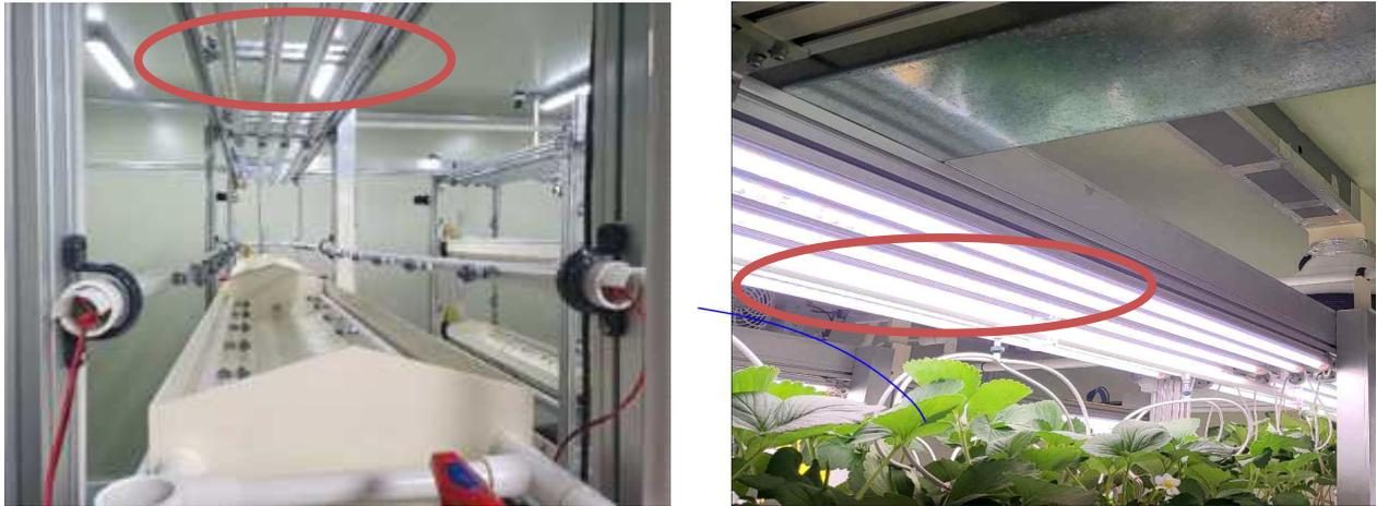
그림 49. LED 설치 4ea(좌), 설치 6ea(우)
