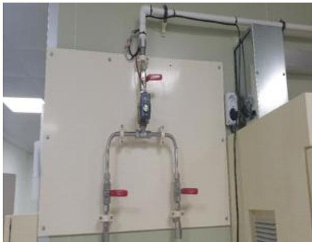
그림 28. CO<sub>2</sub> 공급용 배관 설치
