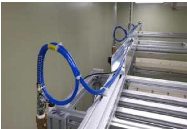
그림 21. 에어배관 설치
