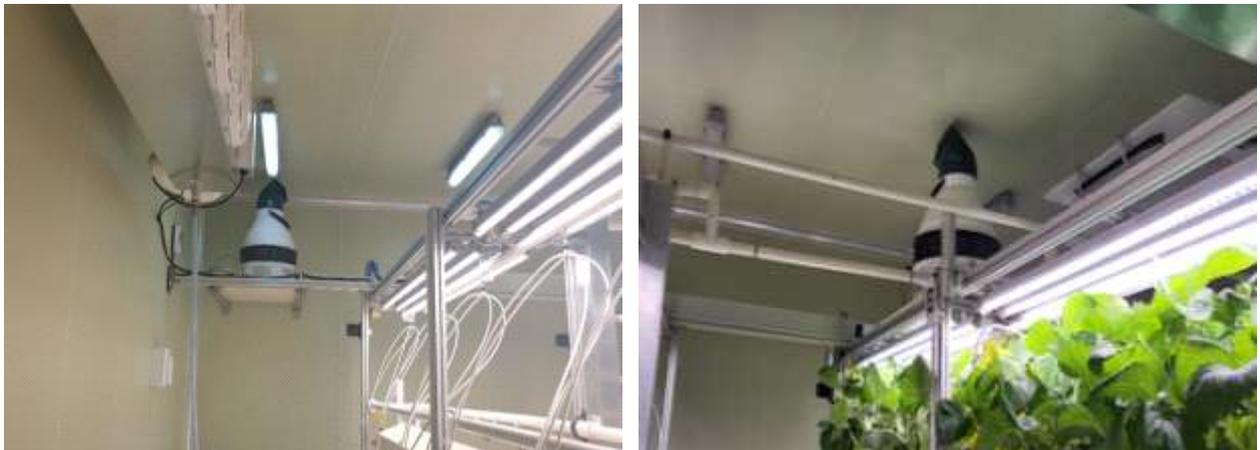
그림 48. 가습기 위치 변경 및 토출구 홀 타공으로 균일한 습도 유지
