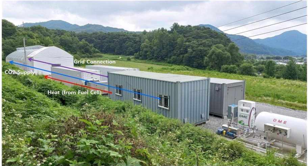
[연료전지-배열회수-축열시스템 LayOut]
