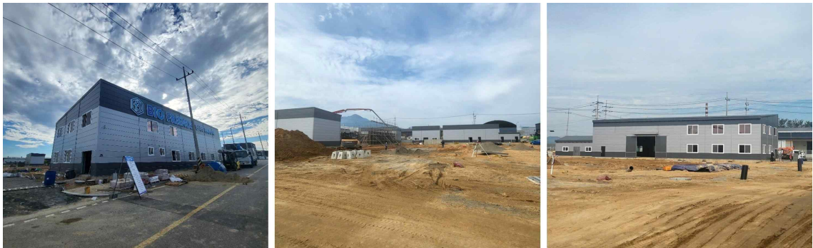
[ (주)바이오프랜즈 제2공장 공사현장 ]
