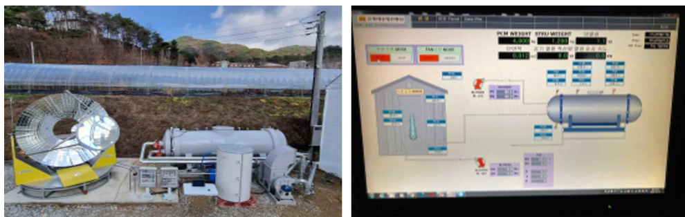
[1GJ급 축·방열 시스템 및 운전화면]
