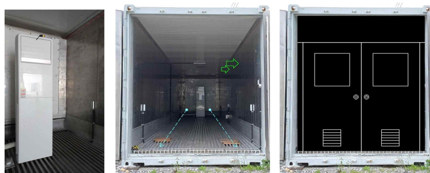
[Air-Flow를 고려하여 Heat-Pump 배치 및 설치]
