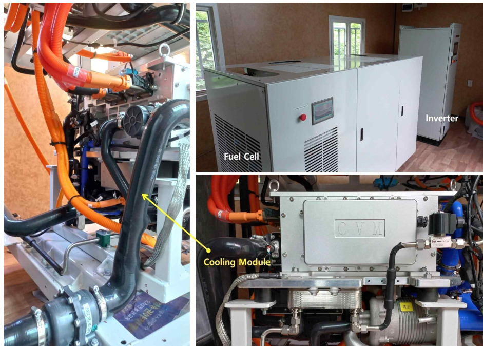
[연료전지, 인버터 / 연료전지 내 Cooling Module]
