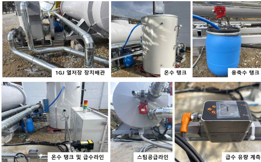
[실증현장 축·방열 시스템 설치 세부요소]
