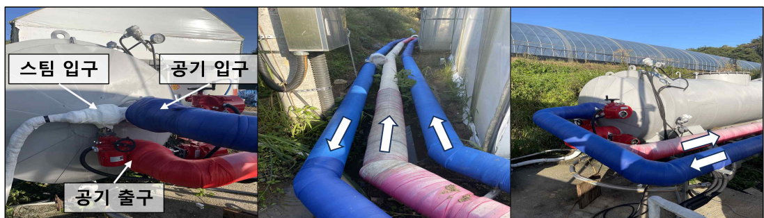
[외부 열공급 배관 구축 및 단열재 설치]
