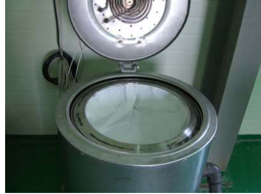
철망통내부에 방근씨트(태피터) 설치
