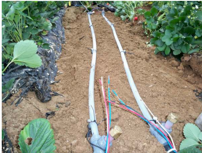
그림3-87 토경재배의 3선식 전열튜브 설치 광경
