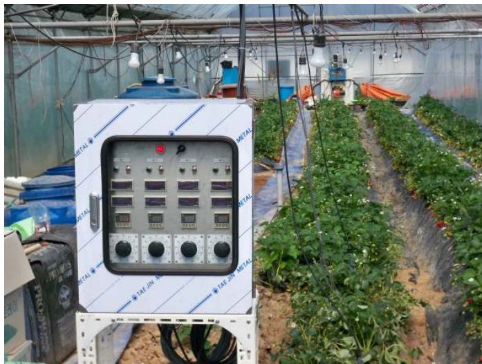
그림3-88 토경재배의 3선식 전열튜브에 의한 지중가온 제어
