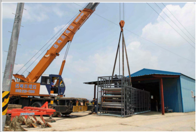
이동순환식건조시스템 설치 작업 장면(3)
