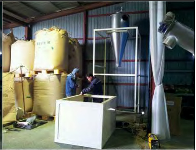
그림 7-55. 녹색WG 원료 정선시스템의 원료정선기 좌대 설치 모습
