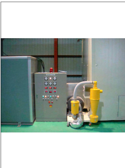
그림 7-32. 컨트롤러 현장 설치
