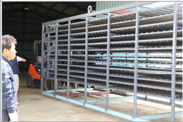
이동순환식건조시스템 설치 작업 장면(5)
