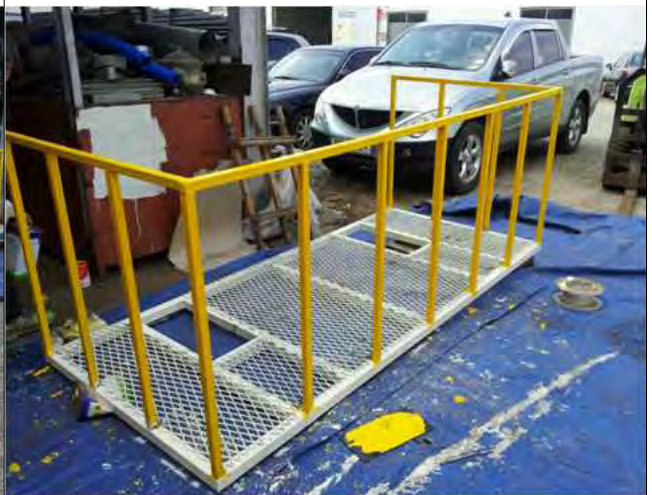
그림 7-53. 녹색WG 원료 정선시스템의 안전점대 설치 전 모습.
