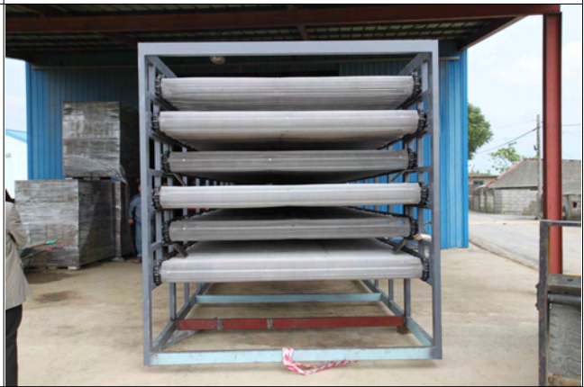
이동순환식건조시스템 설치 작업 장면(6)
