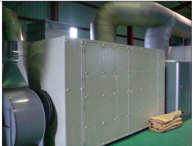
그림 7-22. 제습/냉동 열교환기 현장설치
