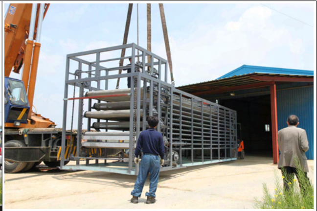
이동순환식건조시스템 설치 작업 장면(2)
