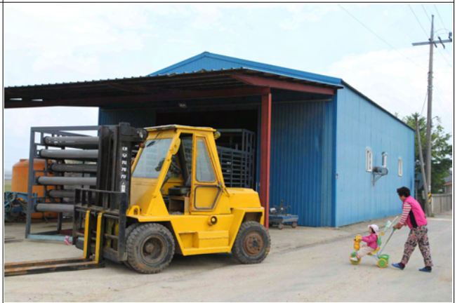
이동순환식건조시스템 설치 작업 장면(4)
