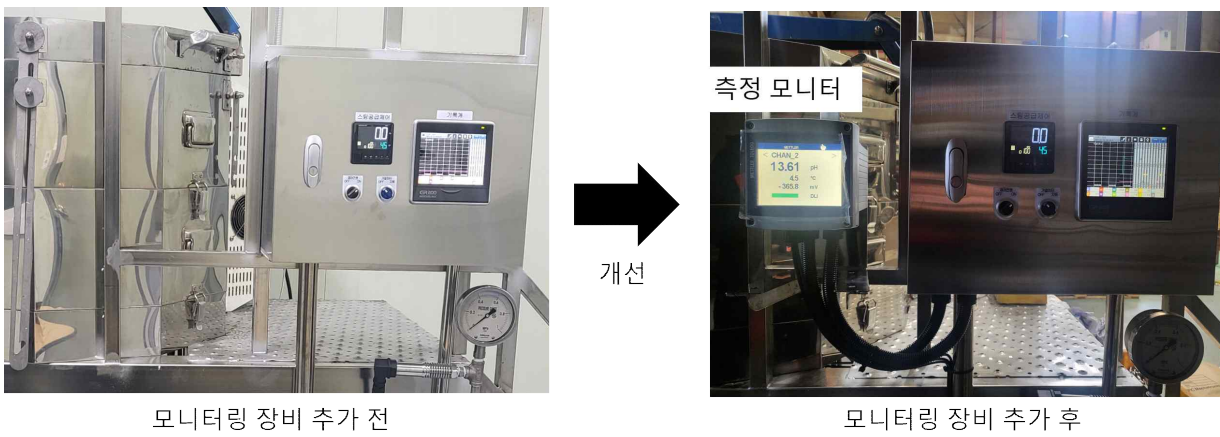
Fig. 133. 측정 수치 모니터링 장비 설치 전후.
