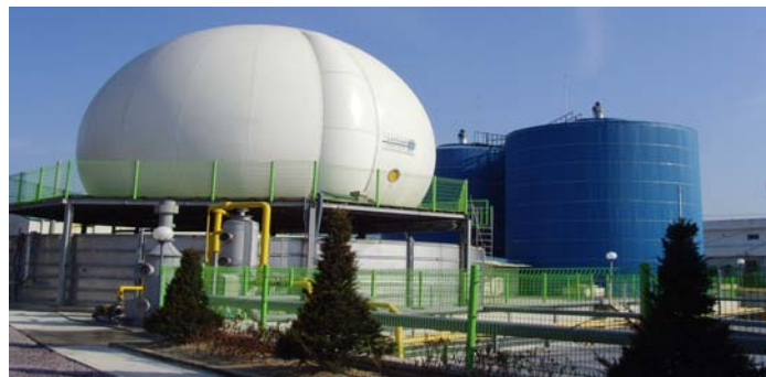
그림 10-9. 가축분뇨 바이오가스플랜트 전경
