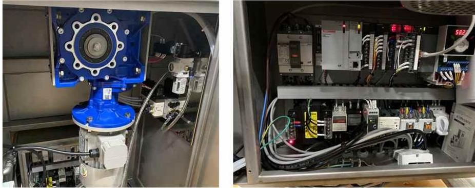
그림29. 냉/온매 순환 펌프와 열교환기 컨트롤러(온도 모니터링 및 제어 시스템)
