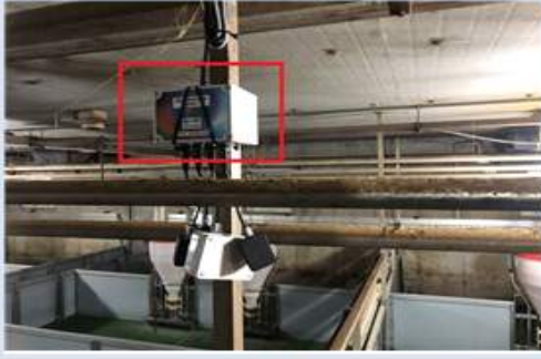
축사 내부 - 센서 6종 필터 상태 점검
