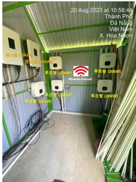
< 60kW급 무음영 영농형 태양광 발전 실증 설비용 인버터 설치(전기실내) >
