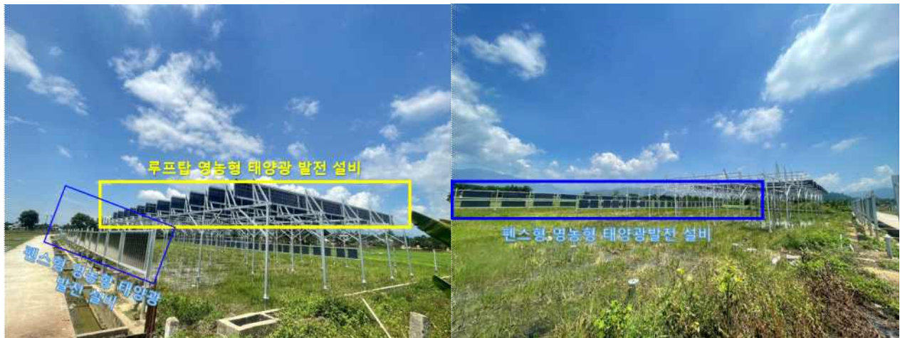
< 20kW 펜스형 및 루프탑형 무음형 영농형 태양광 발전 설비 시공 완료 >
