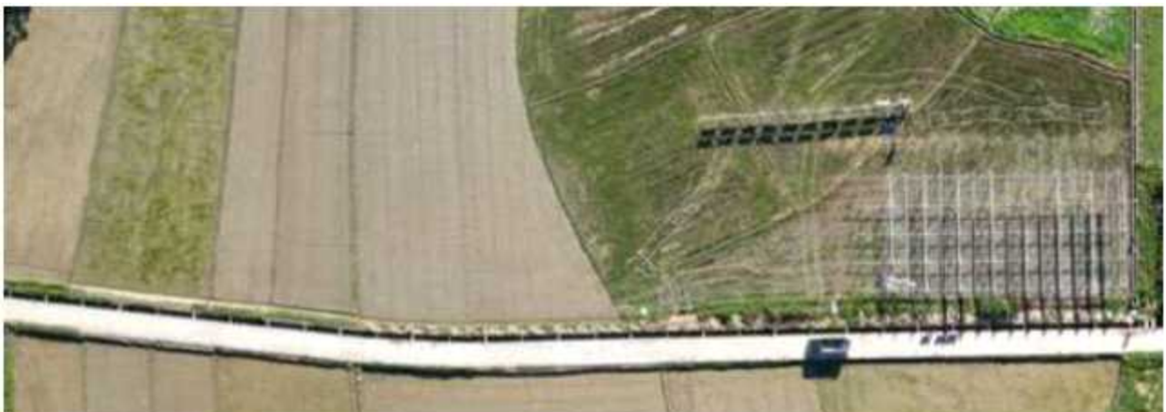
< 베트남 무음영 영농형 태양광 발전 설비 실증 지역 드론 촬영 사진 >
