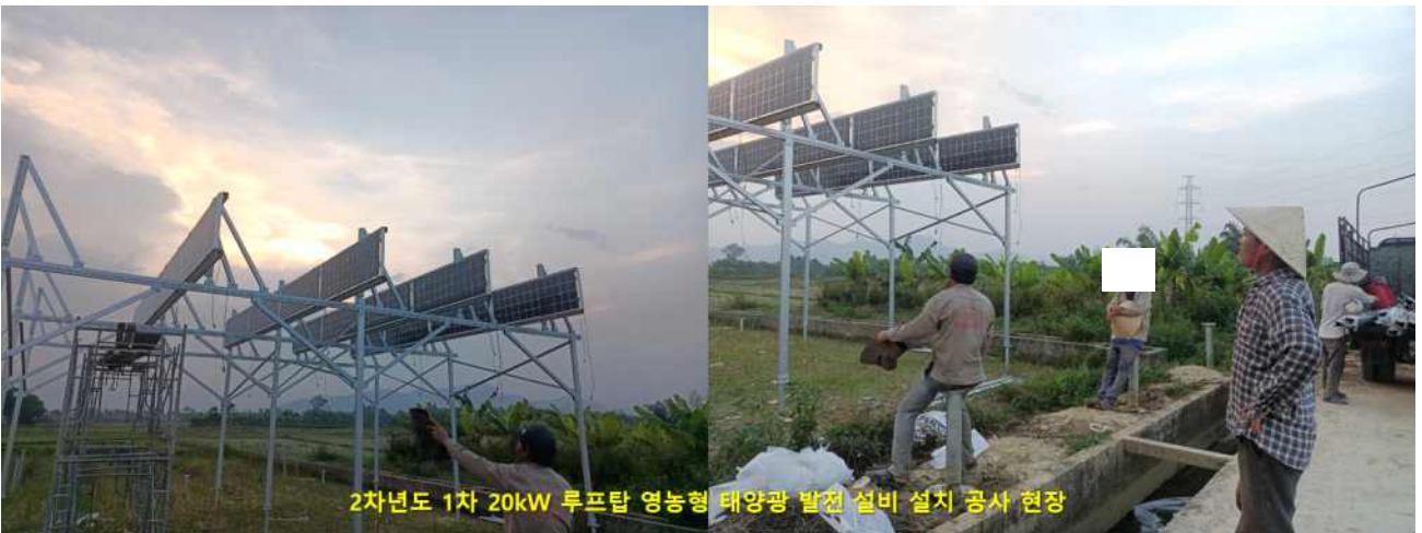
< 2차년도 1차 20kW 루프탑형 무음형 영농형 태양광 발전 설비 공사 현장 >
