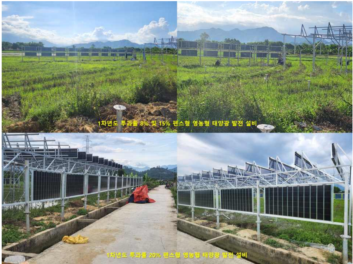
< 1차년도 20kW 펜스형 무음형 영농형 태양광 발전 설비 이동 설치 완료 >
