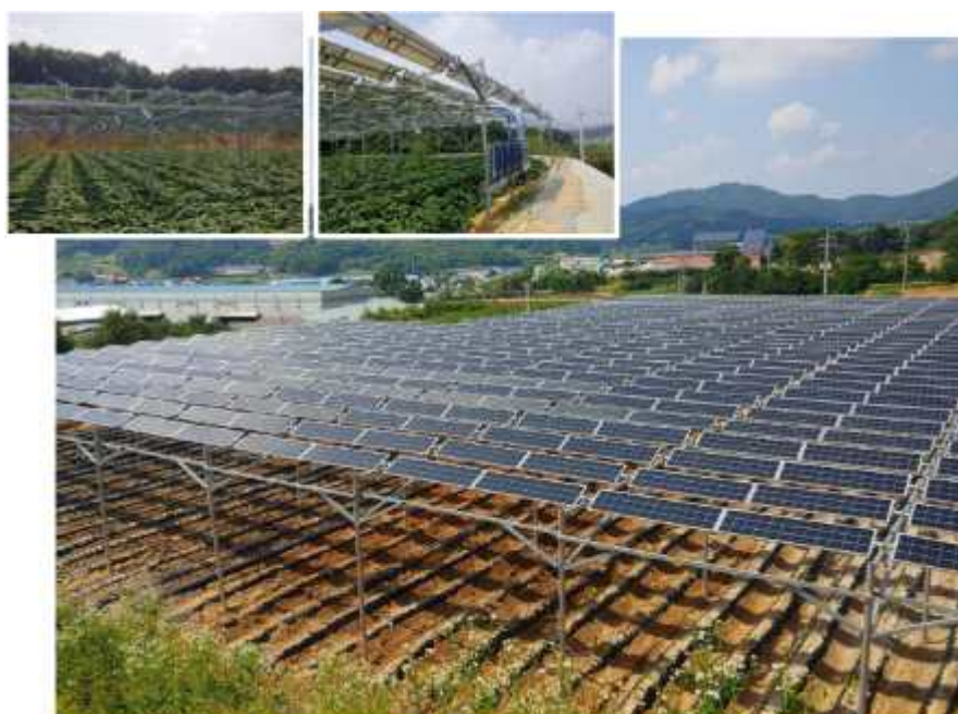
<충북 괴산 밭에 개인이 설치한 99kW급 영농형 태양광 설비 전경>
