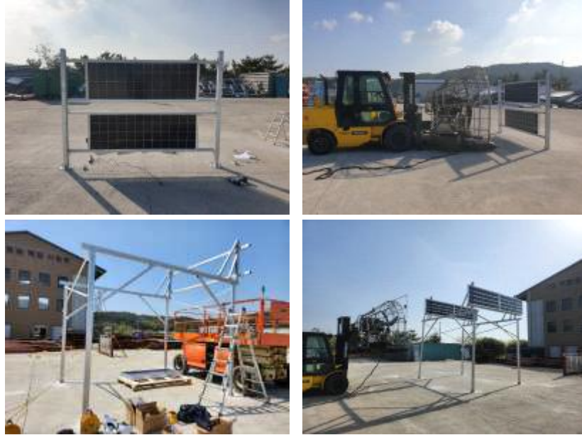
<KCL 수직형, 상부형 구조물 내풍압성시험>
