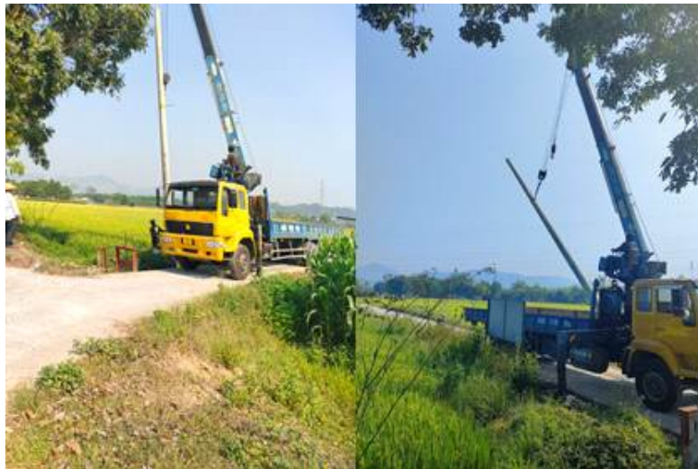
< 계통 연결 전봇대 설치 >
