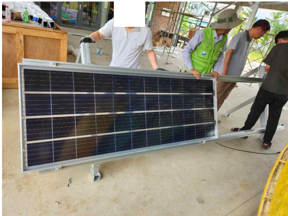
< 영농형 태양광 모듈용 루프탑형 구조물과 태양광 모듈 조립 시뮬레이션 >
