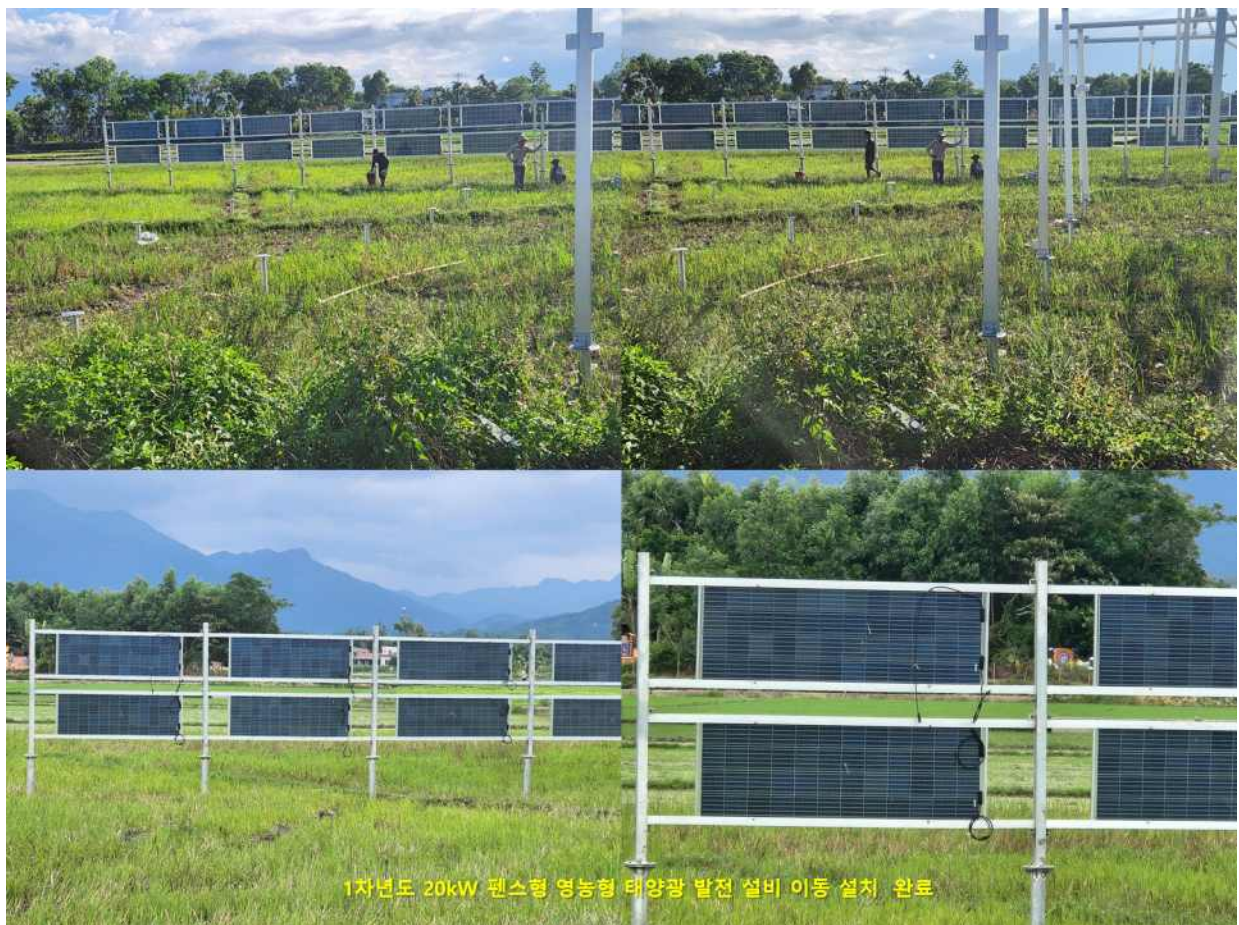
< 1차년도 20kW 펜스형 무음형 영농형 태양광 발전 설비 이동 설치 공사 >
