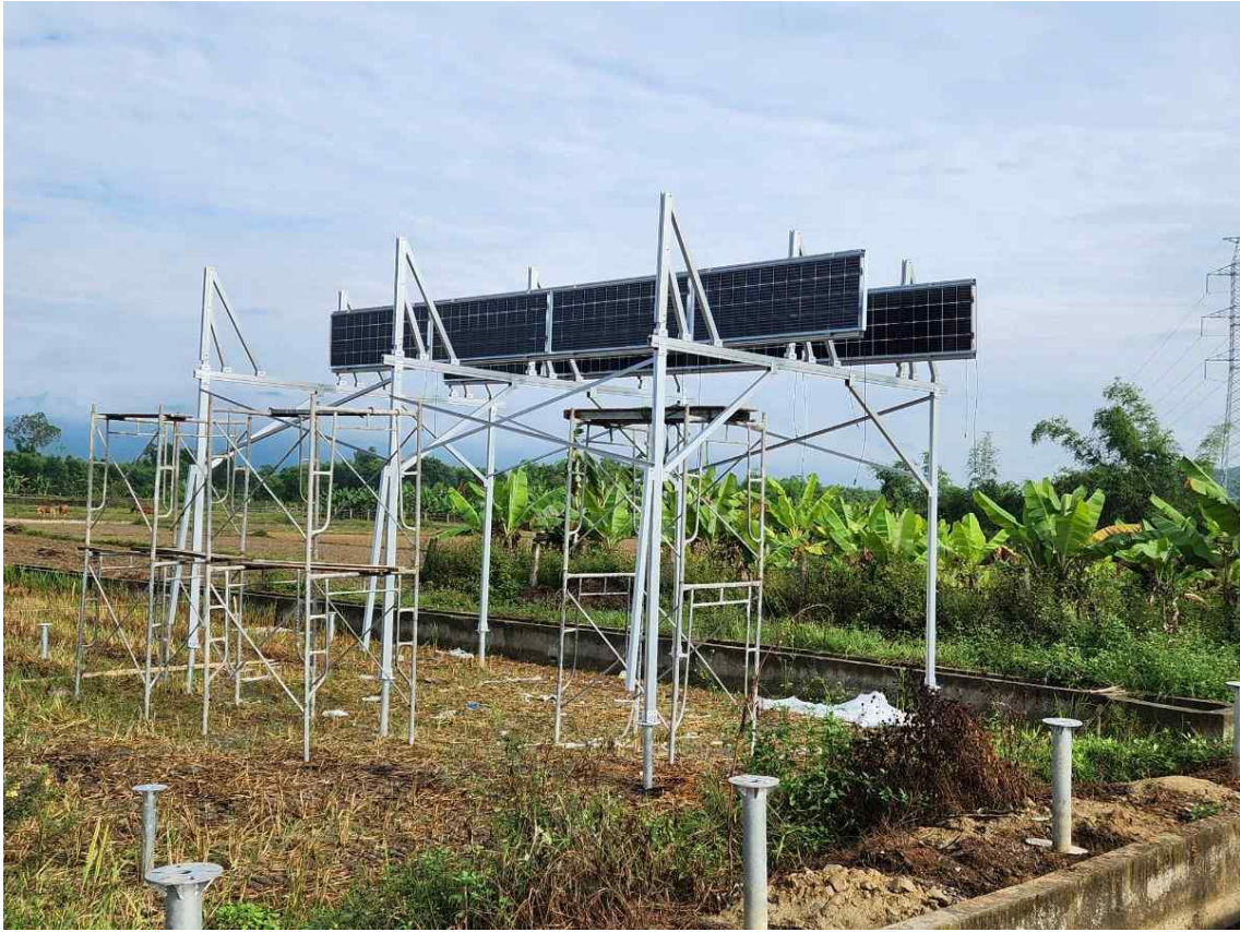
< 루프탑형 영농형 태양광 발전 설비 2set 시공 시연 >
