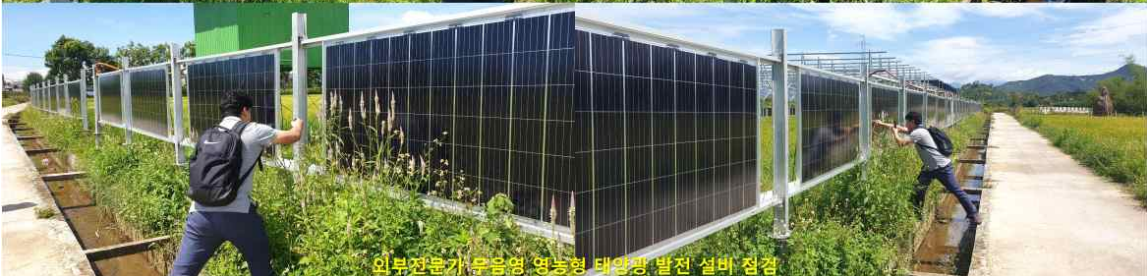
< 무음영 영농형 태양광 발전 설비 외부전문가 점검 >
