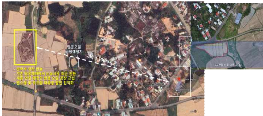
< 펜스형 및 루프탑 무음영 영농형 태양광 발전 실증 설비 설치 지역 >
