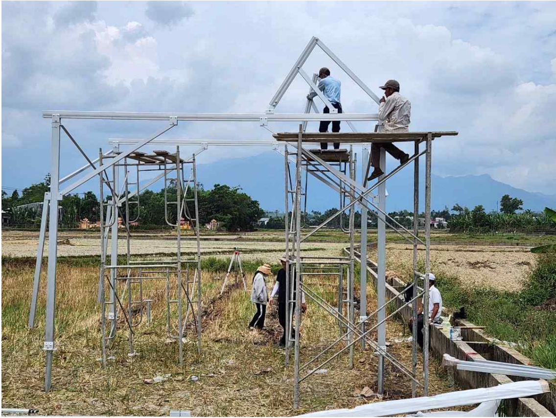
< 루프탑형 영농형 태양광 구조물 조립 기술 교육 및 전수 >
