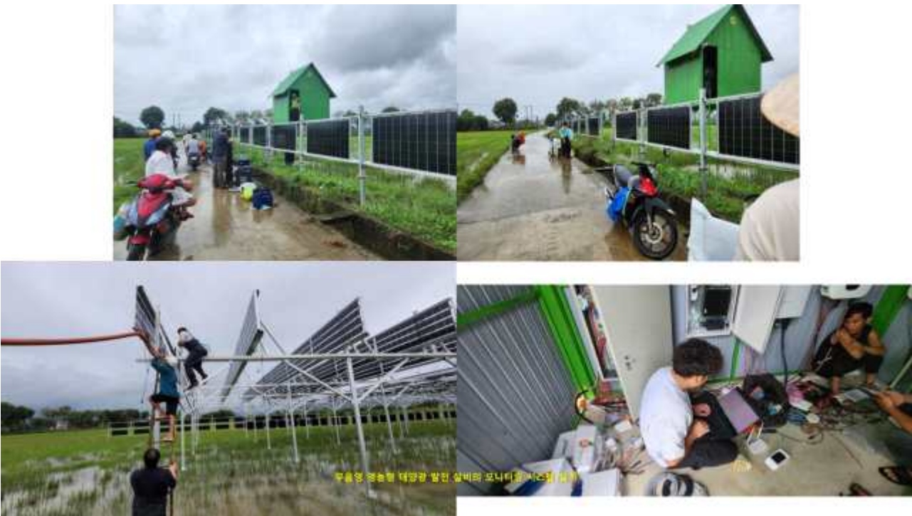
< 무음영 영농형 태양광 발전 실증 설비 모니터링 시스템 설치 현장 >
