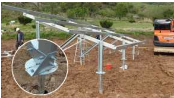
상부 구조물 기둥 및 모듈 가대 체결
