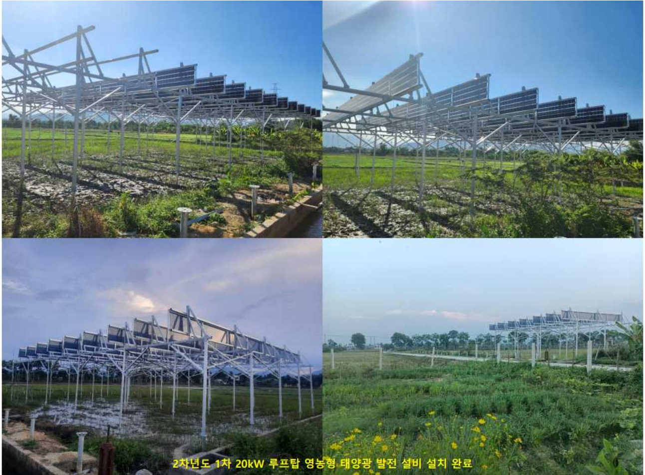
< 2차년도 1차 20kW 루프탑형 무음형 영농형 태양광 발전 설비 시공 완료 >
