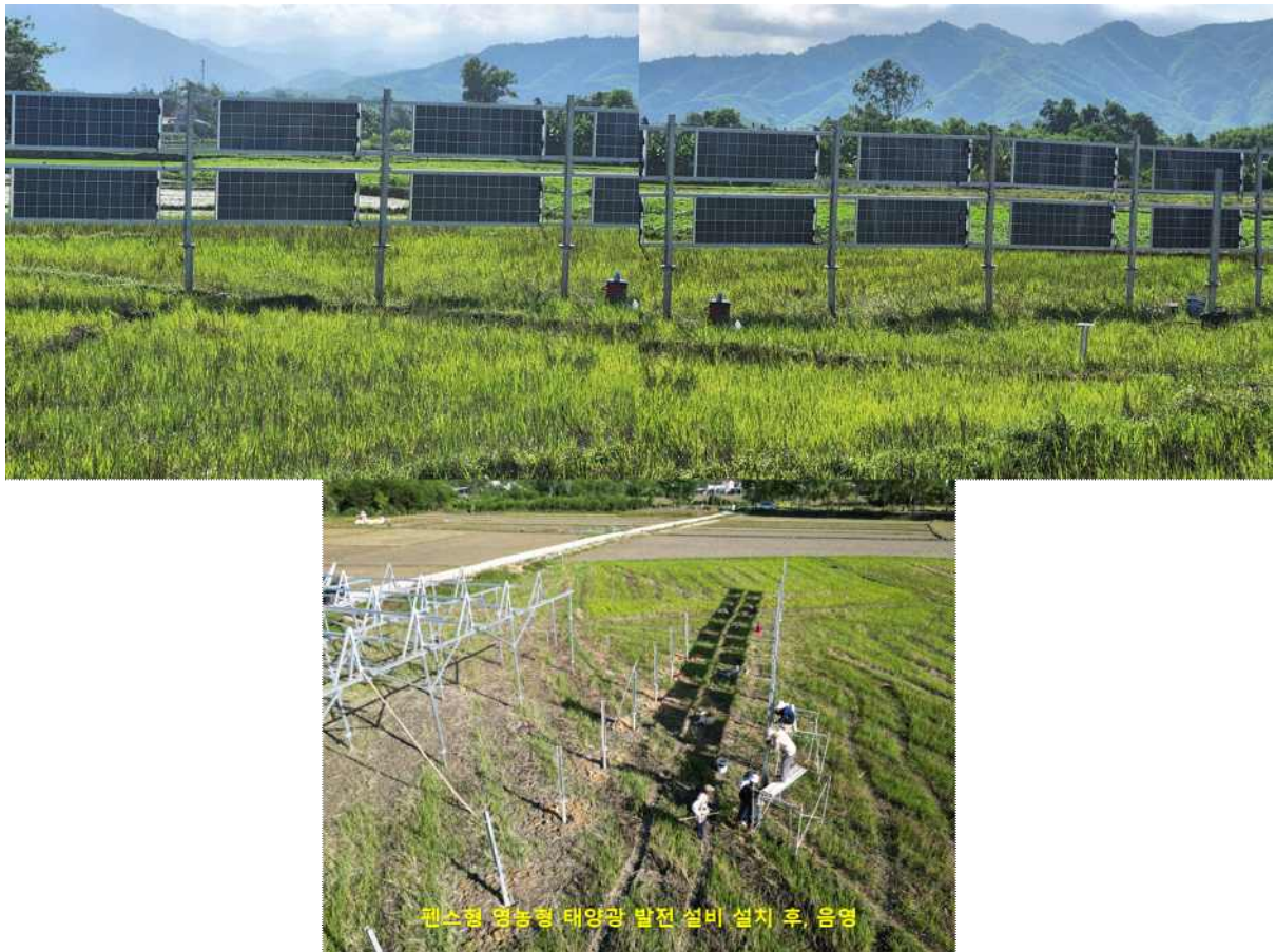
< 펜스형 영농형 태양광 발전 설비내 음영 >
