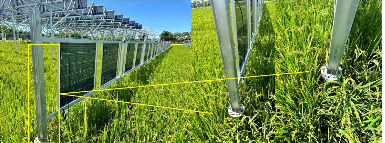
펜스형 무음영 태양광 발전 설비의 구조물 주변 작물 생육 점검
