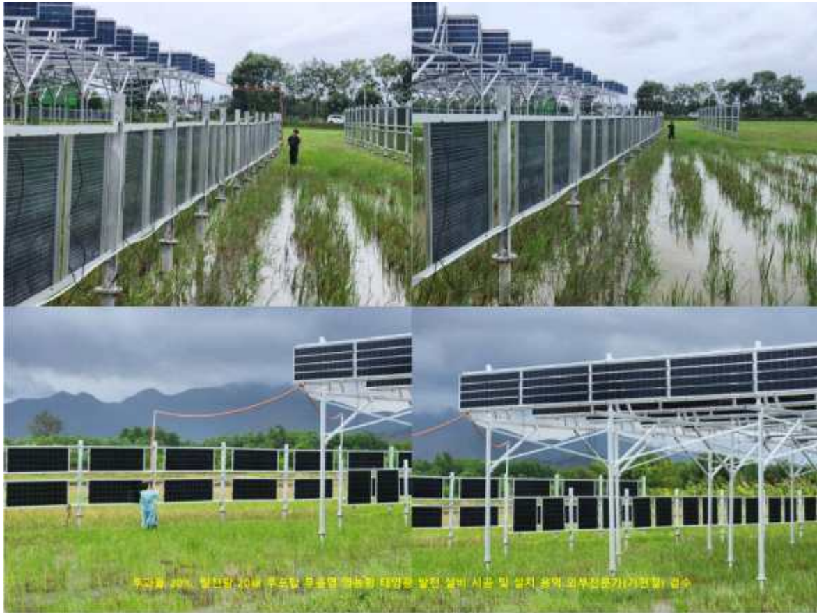
< 무음영 영농형 태양광 태양광 발전 설비 입회 용역 검수 및 시험 >
