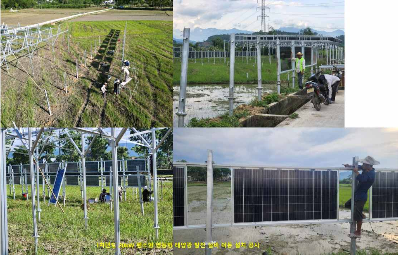
< 1차년도 20kW 펜스형 무음형 영농형 태양광 발전 설비 이동 설치 공사 >
