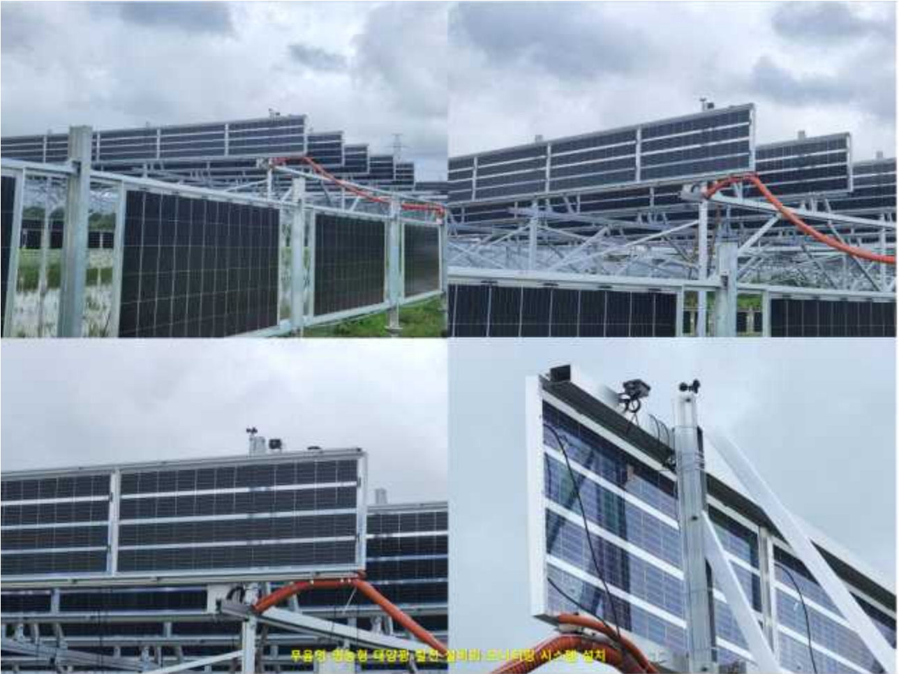
< 무음영 영농형 태양광 발전 실증 설비 모니터링 시스템 설치 완료 >
