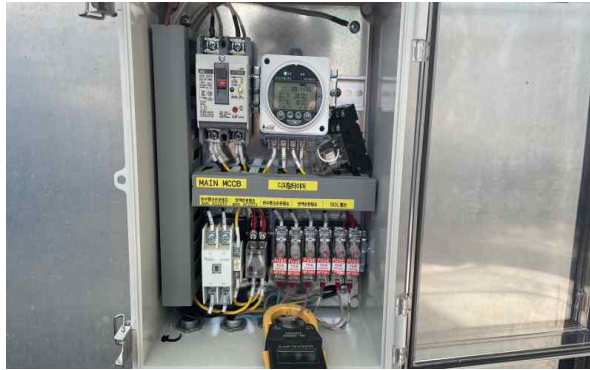
양액공급, 온도제어기 설치, 시운전
