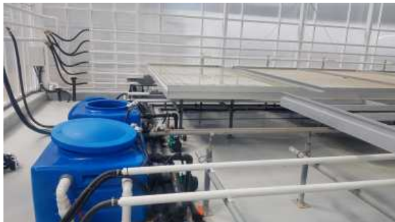
양액 냉난방 탱크 및 배관설치
