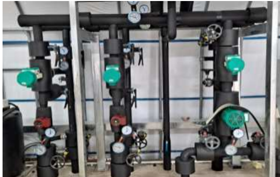
국소냉난방 장비, 배관 설치
