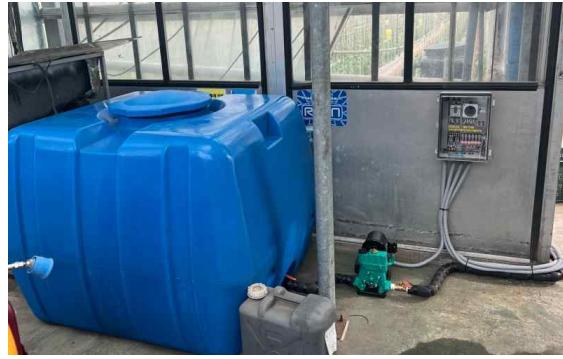
실증용 양액탱크 설치
