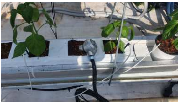
국소냉난방 열교환기, 센서 설치
