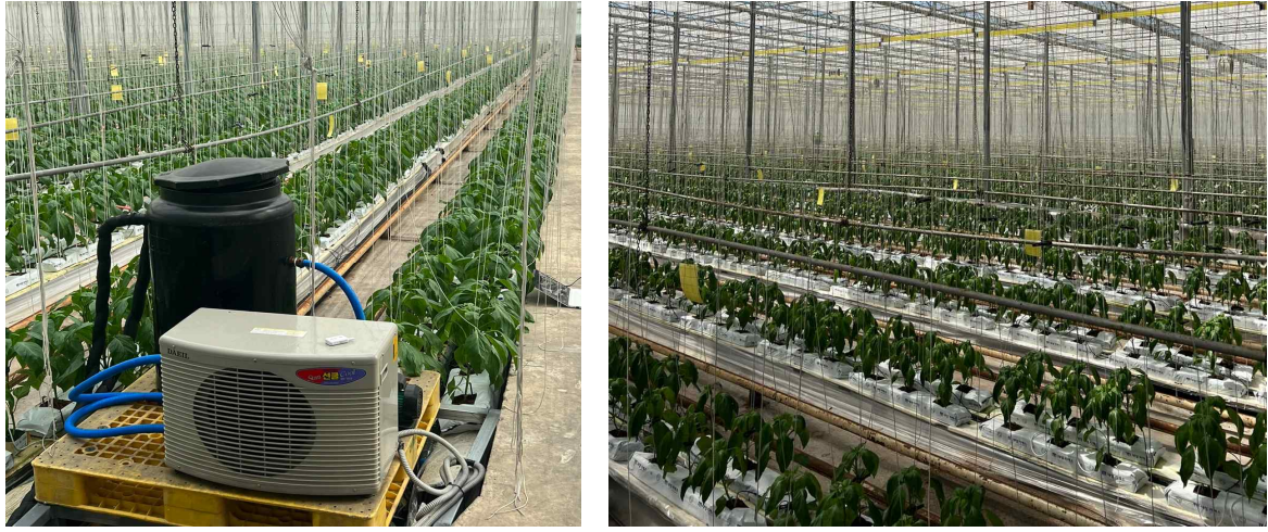
그림 9-41. 하이브리드 냉난방 시스템이 설정된 온실 내부
