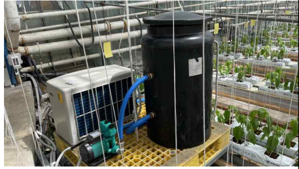
히트펌프, 국소냉/난방탱크 설치
