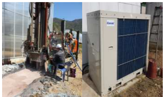
지열 / 공기열 히트펌프 설치
