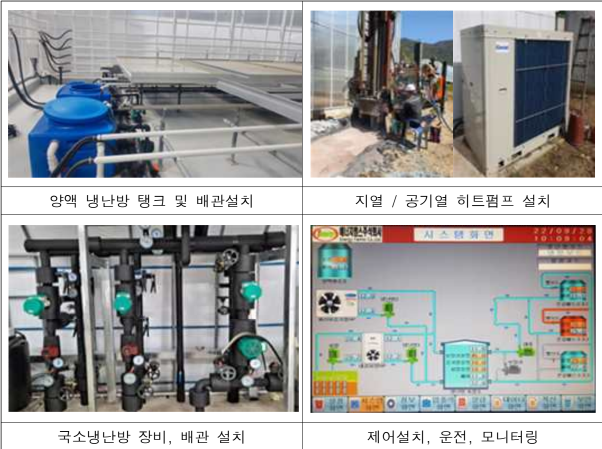
그림 7-20. 목포대 복합열원 시스템 설치
