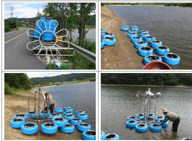
[그림 3.2.53] 교반장치를 이용한 인공식물섬 현장설치 작업 및 설치전경
