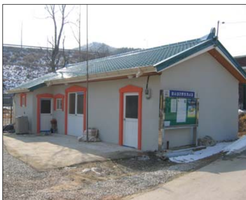
<그림 103> 경사지붕의 설치
