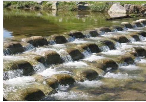
<그림 16> 자연석 블록을 이용한 계단식 어도
