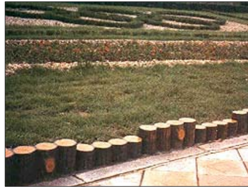
<그림 92> 목재를 이용한 녹지경계목
