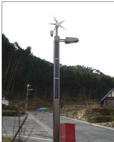
<그림 89> 태양열을 이용한 가로등
