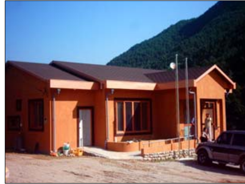
<그림 63> 콘크리트로 건조하고 외벽은 황토
