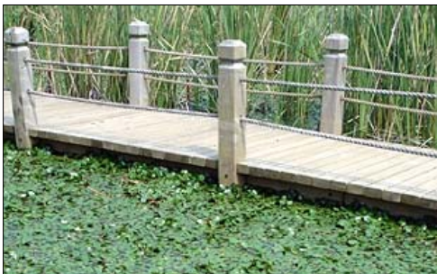
<그림 23> 목재 난간을 설치한 데크 (파주 헤이리)
