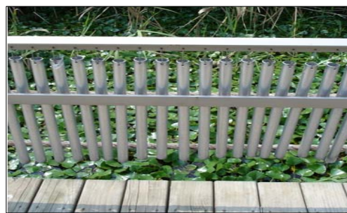
<그림 24> 소리철 난간을 설치한 데크 (파주 헤이리)
