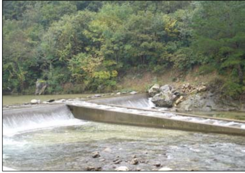
<그림 15> 콘크리트로 만든 일반적인 계단식 어도
