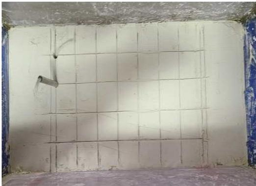
그림 2-54 배수재 설치
