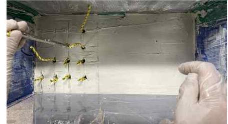
그림 2-62 배수재 설치
