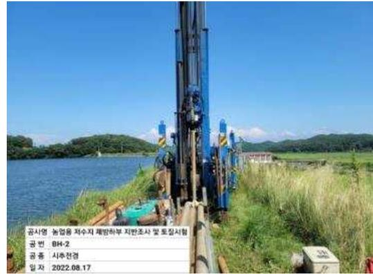
그림 2-11 저수지 제방 하부 지반조사(중장저수지)
