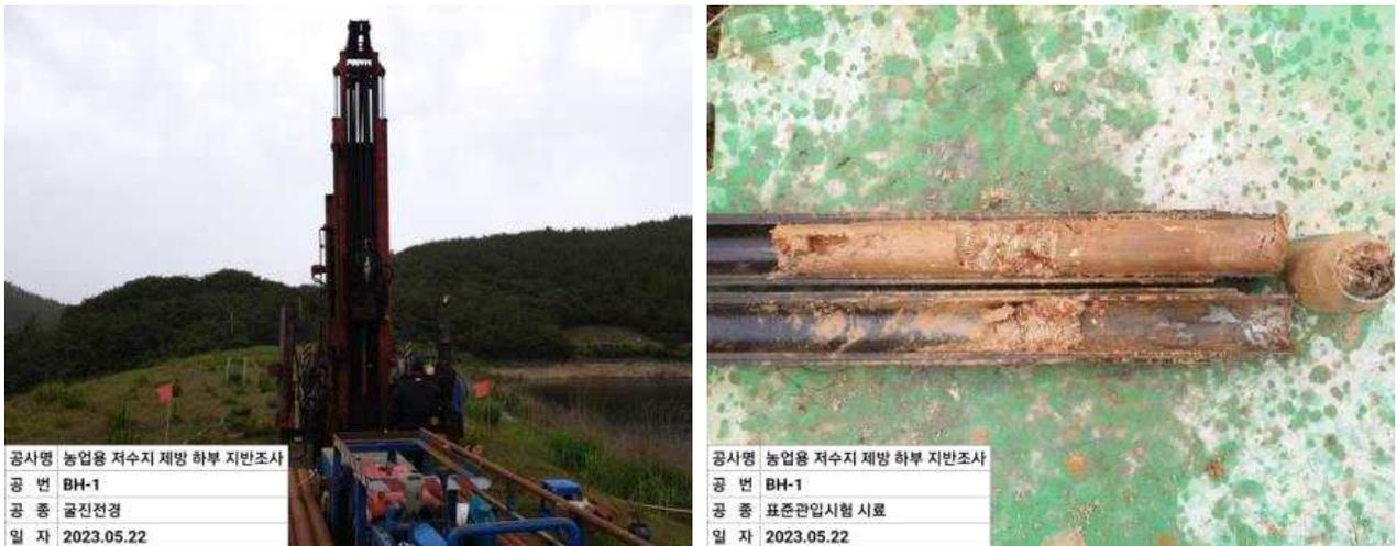
그림 2-15 저수지 제방 하부 지반조사(탄동저수지)
