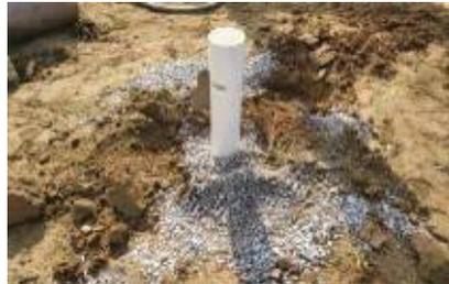
그림 2-116 지반 천공 및 센서 설치
