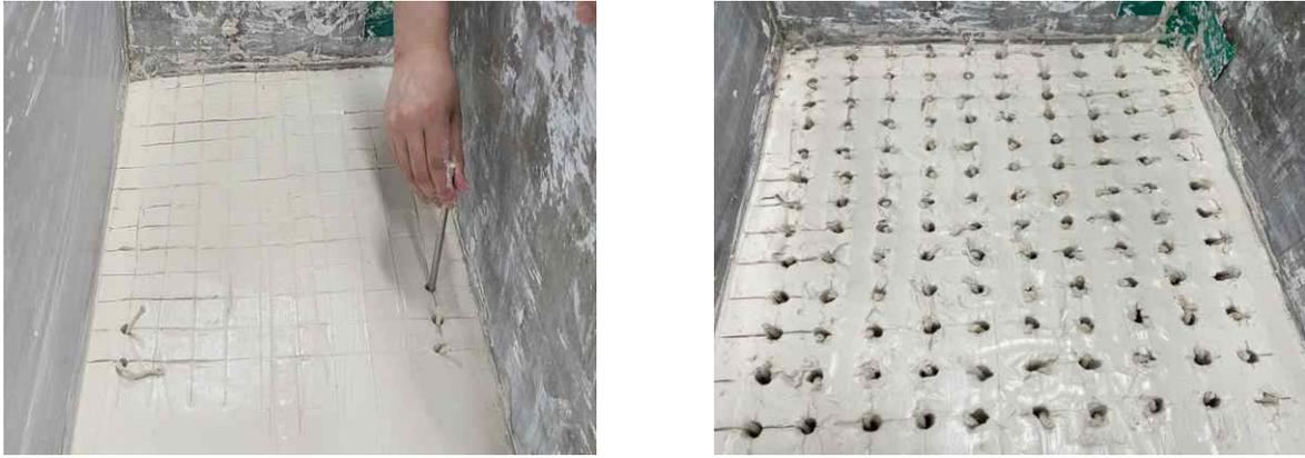
그림 2-68 배수재 설치
