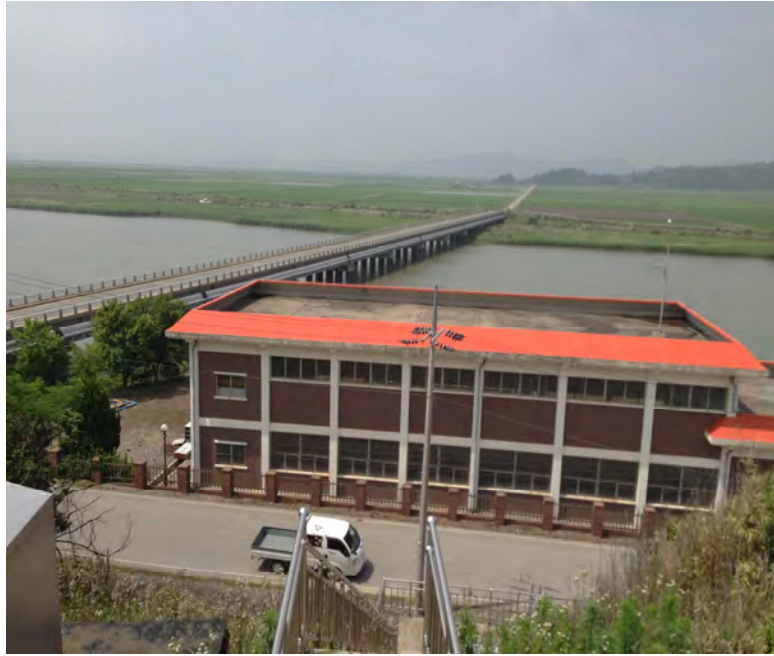
[그림 3-3-4-7] 연곡양수장 전경
