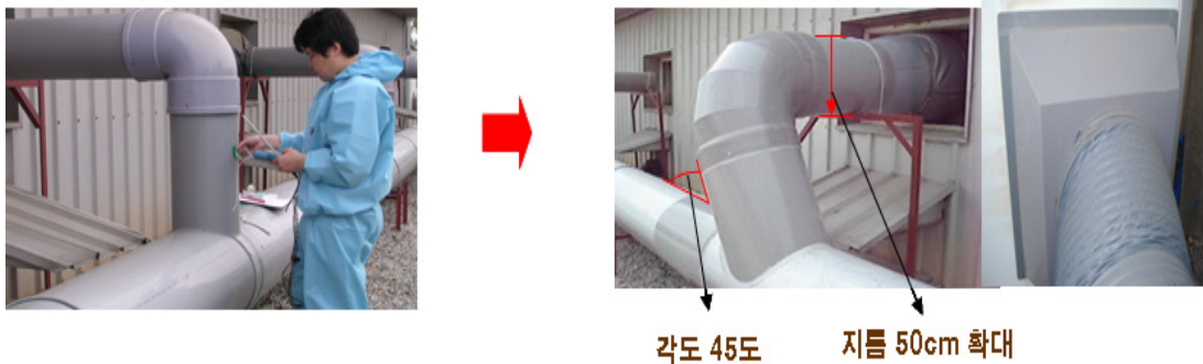
그림 11. 바이오필터의 환기덕트 및 메인덕트 구조변경
