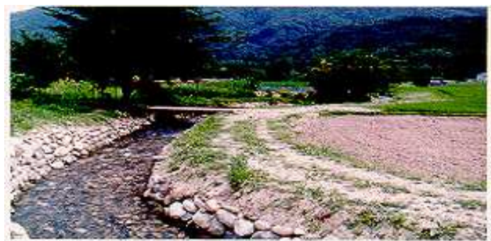
그림 4.2.19 자연석을 이용한 수로바닥 시공 사례
