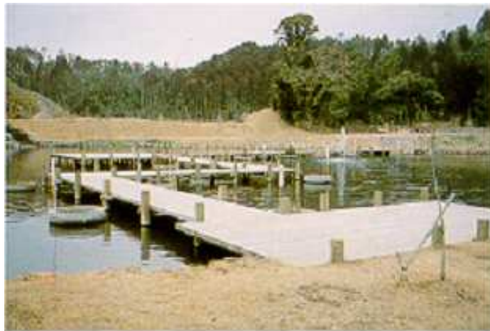
(b) 연못 시공 사례
