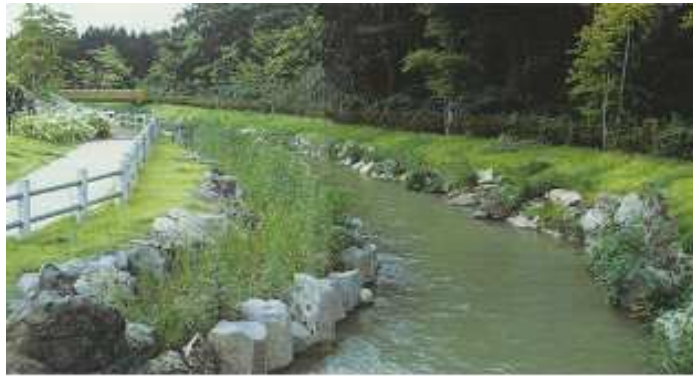
그림 4.2.18 산책로 시공 사례
