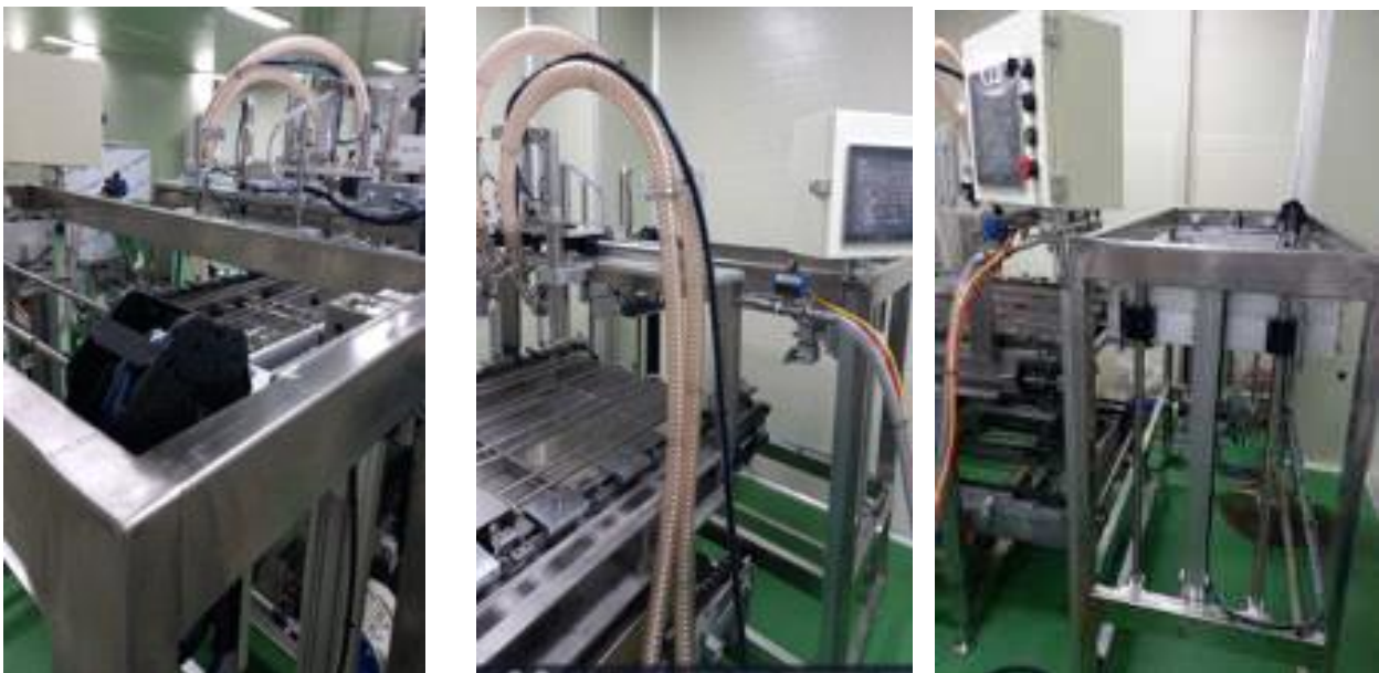
그림 29) LOADING LIFT Unit 제작 및 설치
