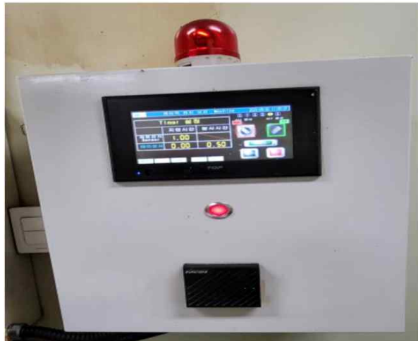
그림 42) 오일자동분사장치와 컨트롤 패널부 제작 및 설치
