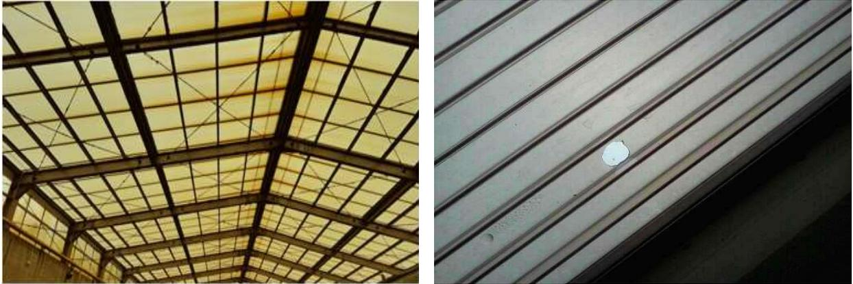
그림 1-3. 당사가 시공한 PC 복층골판의 황변(좌) 및 깨짐 현상(우)
