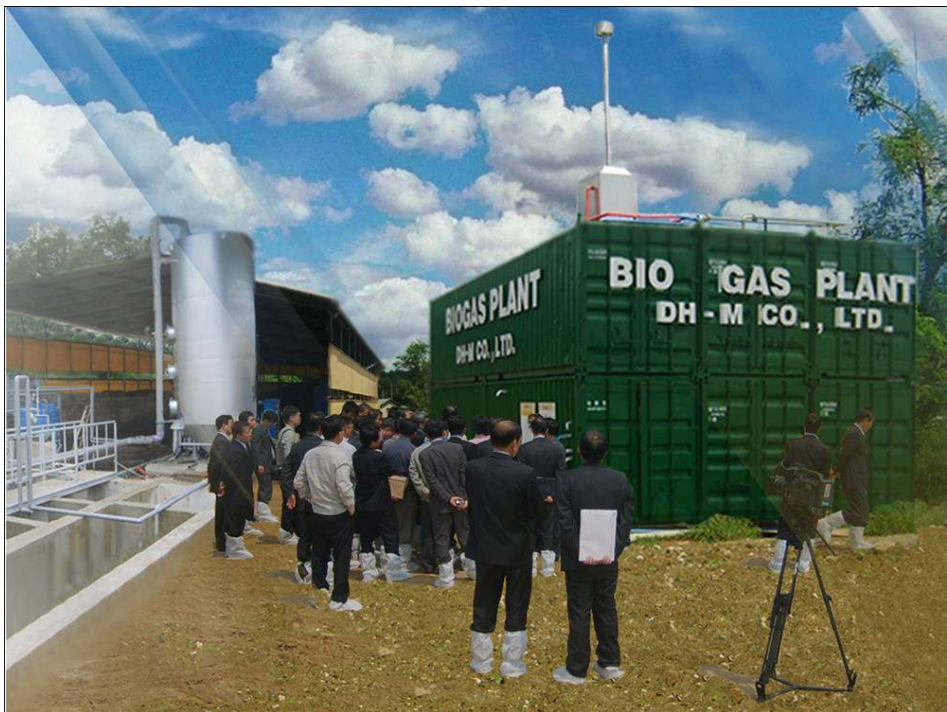
그림 106 본 바이오가스 플랜트 및 정화처리시스템(연구개발 결과물) 돈분 10톤/일 규모 바이오가스 플랜트(20kw) 및 정화처리시스템 설치 사진 (충청남도 홍성군)
