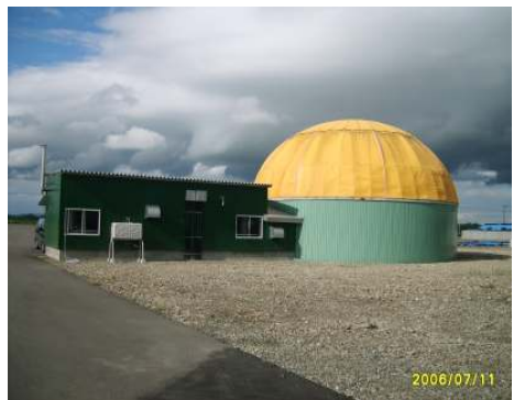
그림 104 바이오가스플랜트의 저장조형태
