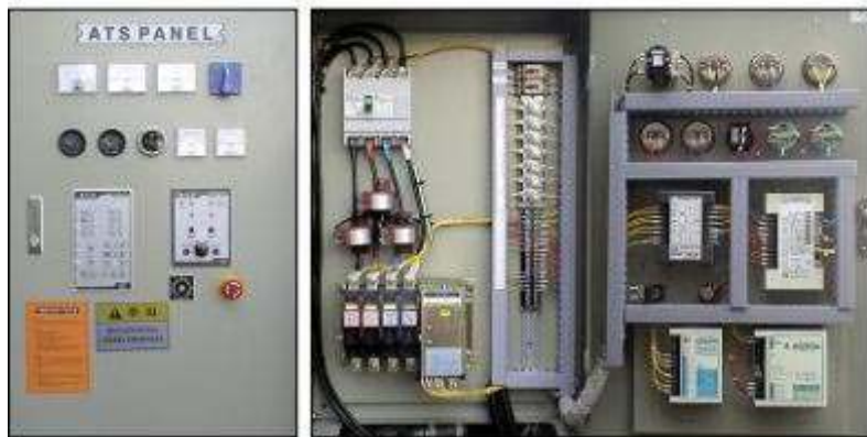
그림 30 임시 농가 설치용 ATS 시스템 판넬
