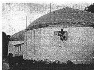
Bild 7: Wärmegedämmte Stahlbetonfermenter mit einem Gärvolumen von je 1150 m 3 , Rührwerk und Doppelfoliengasspeicher in einer einstufig betriebenen mesophilen Durchflussanlage
