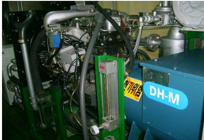
그림 68 20kW급 바이오가스와 디젤 혼소형 발전시스템
