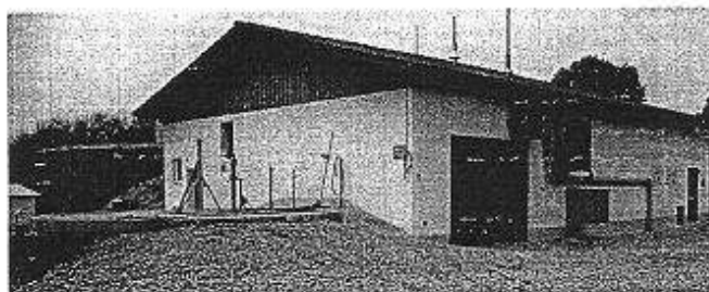
Bild 5: BHKW-Einhausung mit großem Gaslager für die Zwischenspeicherung zur Gasverwertung in den Spitzenzeiten
