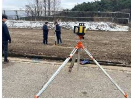
사진 12. 균평 후 측정 작업 (기성 제품)
