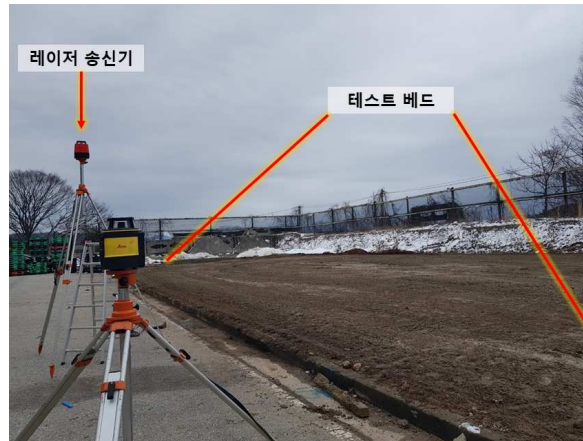
[테스트 베드 및 레이저 송신기 위치]
