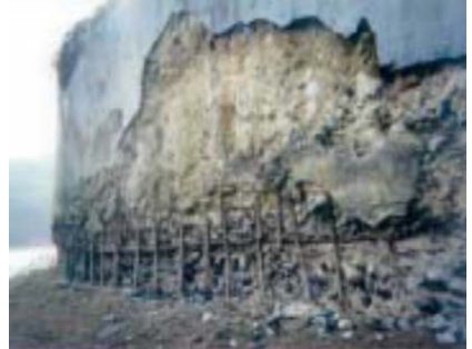
<그림 2.1> 노후화된 농업 수리시설 콘크리트 구조물
