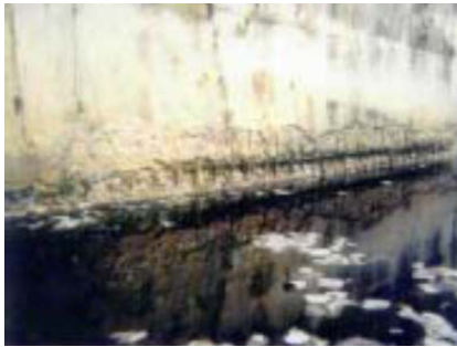
<그림 2.1> 노후화된 농업 수리시설 콘크리트 구조물
