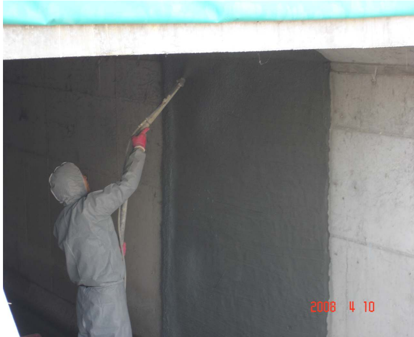
<그림 3.68> 현장시험시공시 뽐칠작업 모습
