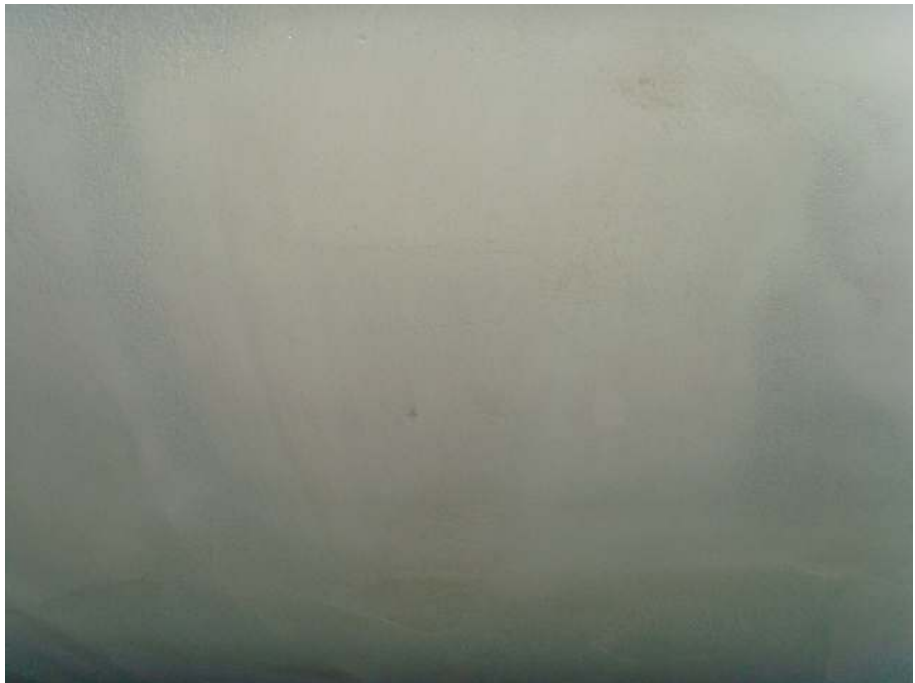
시공완료 후 시공면 상태모습
