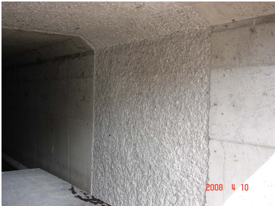
시공면 절삭작업 완료 후 모습
