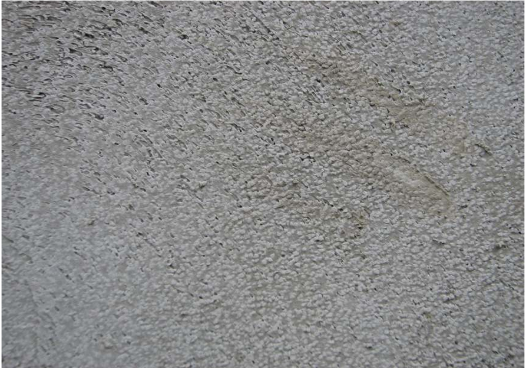
<그림 3.52> 스프레이 작업 완료 후 시공면 상태
