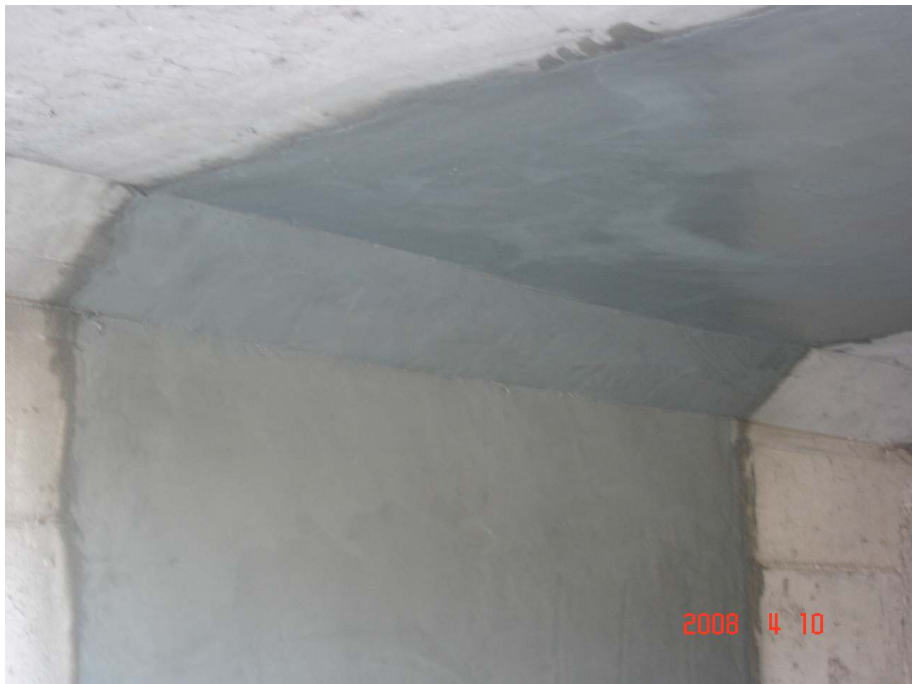
시공완료 후 시공 면상태 모습
