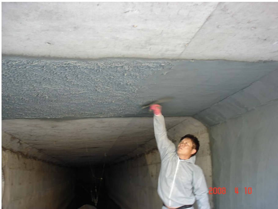
시공면 마무리 작업 모습
