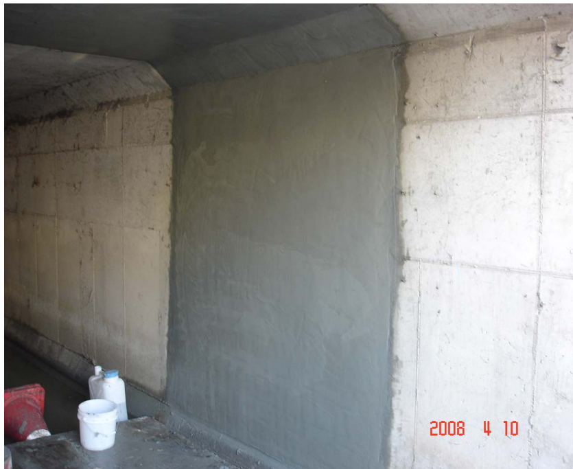
<그림 3.69> 현장 시험시공 완료 후 시공 마무리면
