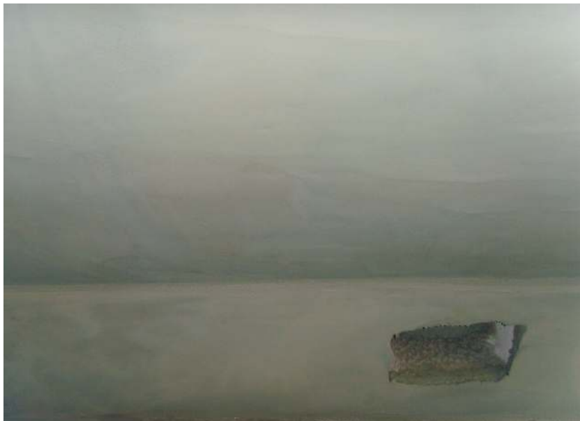
<그림 3.65> 현장 Mock-up시험 완료 후 시공 마무리면
