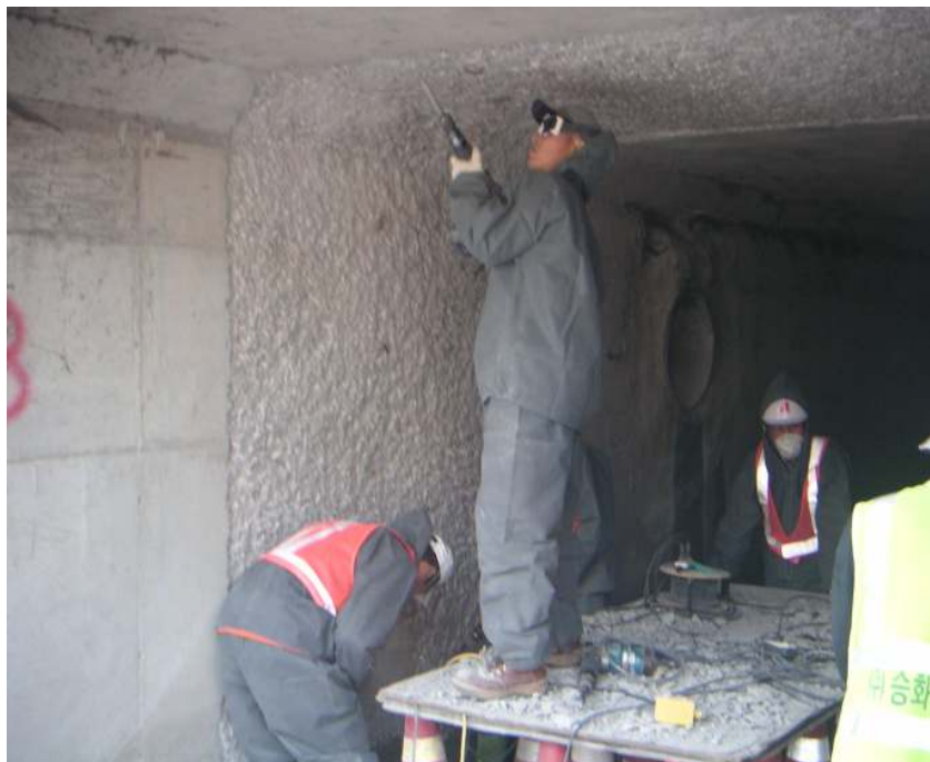
<그림 3.67> 현장 시험시공시 시공면의 치핑작업
