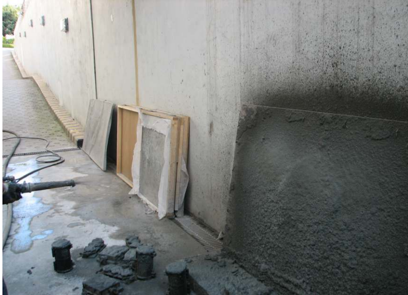
<그림 3.50> 스프레이 타설장비를 이용한 스프레이 작업모습
