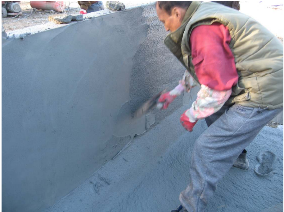
시공면 마무리작업 모습
