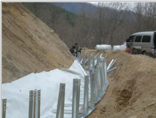
그림 4-15. 터파기 한 후 부지포 도포
