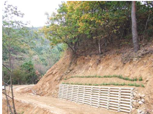
그림 2-6. 친환경 목재틀 옹벽 시공
