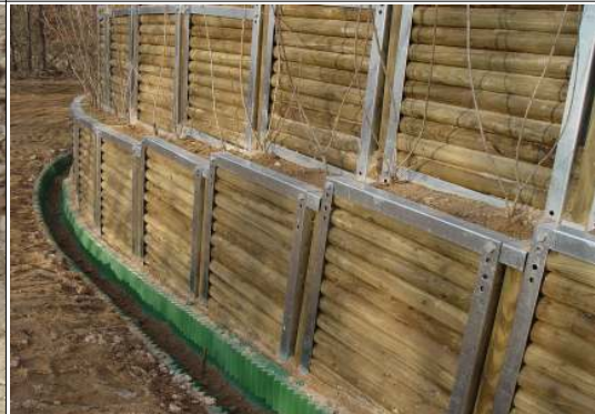
그림 4-24. 시공 후 뒷정리 한 모습
