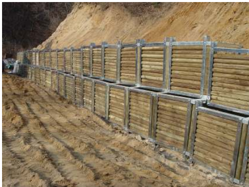
그림 5-3 . 조립식 임도옹벽 시공 현장
