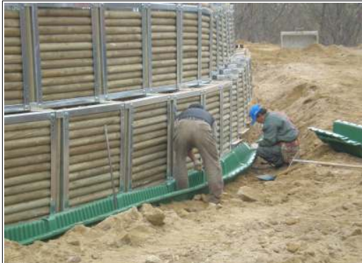
그림 4-21. 옹벽 조립 후 측구 부착
