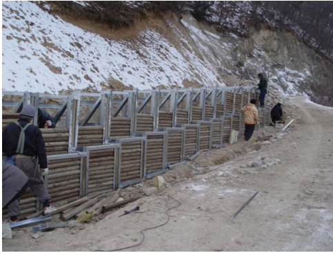
그림 5-1. 동절기에 임도옹벽 시공
