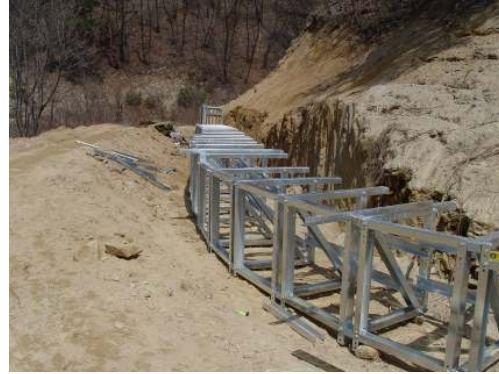
그림 5-6. 곡선임도 옹벽시공 현장
