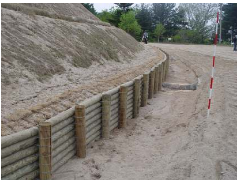
그림 2-5. 리기다 방부목 옹벽 시공
