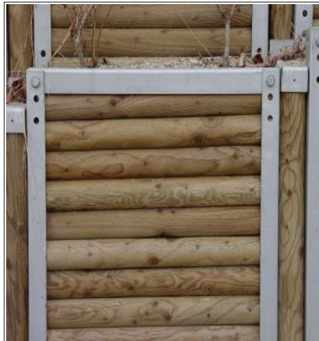
그림 3-35 방부목의 상태
