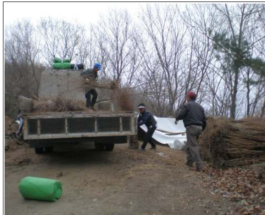
그림 4-11. 시공 후 식재 할 묘목 하차
