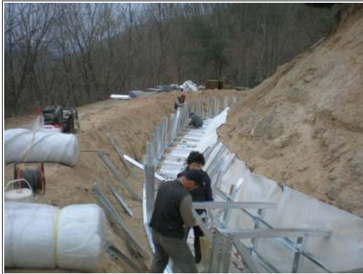
그림 4-17. 곡선임도의 시작품 조립 모습
