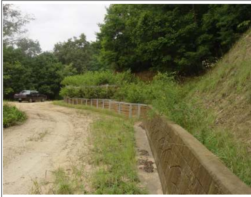
그림 3-45 2차 시공 현장
