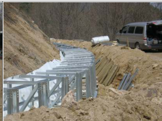
그림 4-16. 부지포 도포 후 조립 형틀 정리
