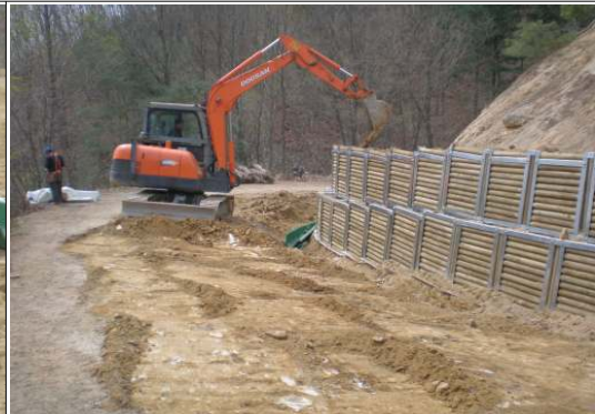
그림 4-22. 조립후 흙으로 뒷채움 모습
