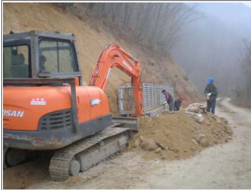
그림 4-13. 1차년도임도옹벽 연결 터파기
