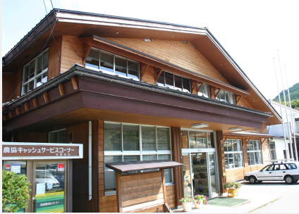
동사무소(域場, 맞배지붕)
