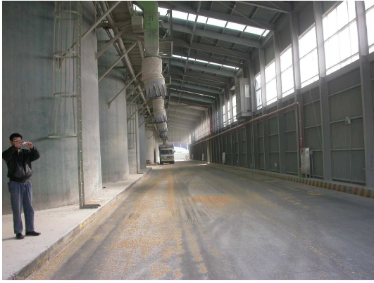
[ 싸이로(SILO) 출고 장면 ]
