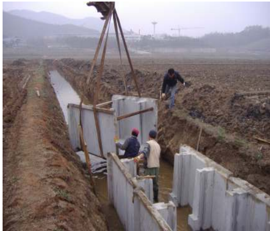
<그림 3.2.17> 수질정화수로관 본체 설치
