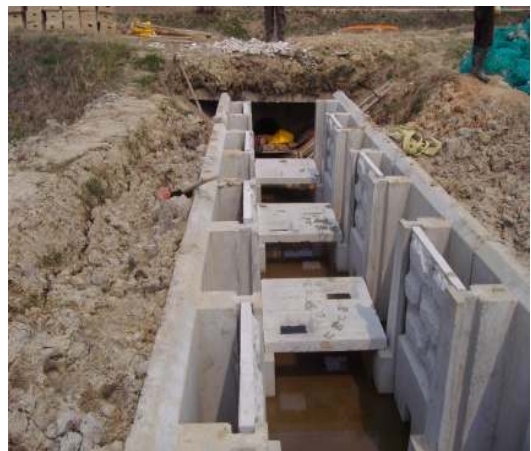
<그림 3.2.18> 옆판 및 밑판 설치
