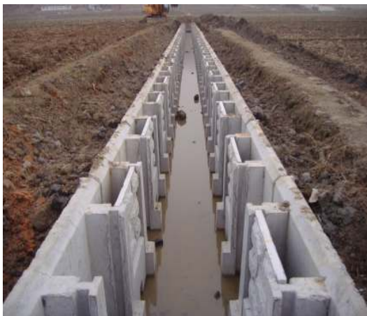
<그림 3.2.18> 옆판 및 밑판 설치
