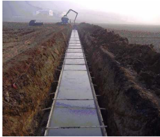
<그림 3.2.16> 시험수로의 토공 및 기초 타설
