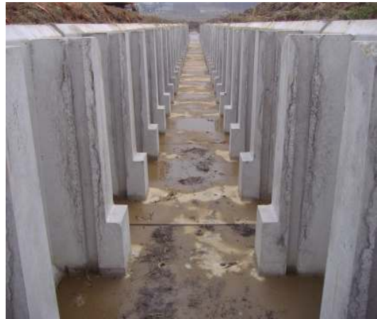
<그림 3.2.17> 수질정화수로관 본체 설치
