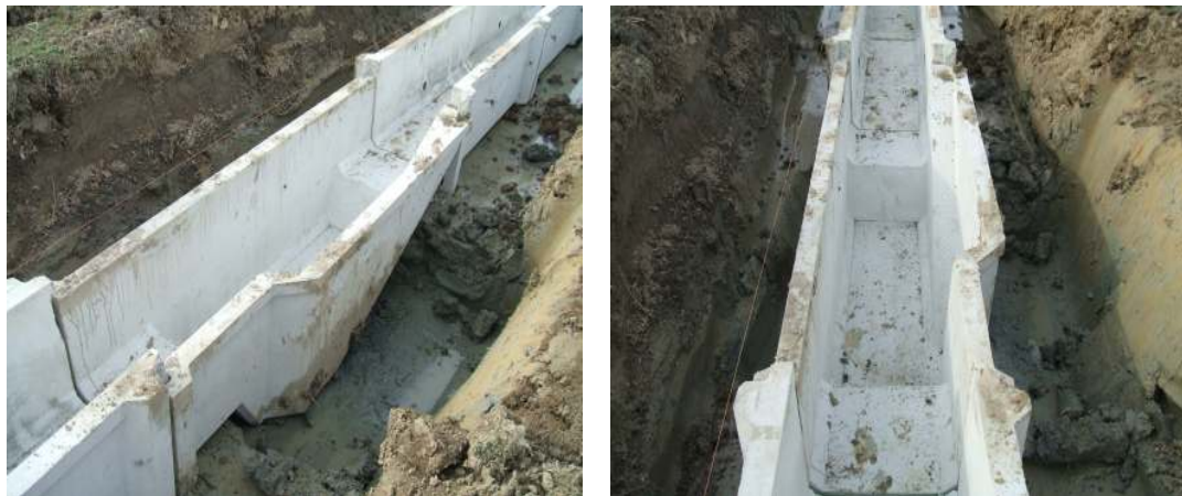
<그림 3.2.20> 환경생태보호형수로관 시공
