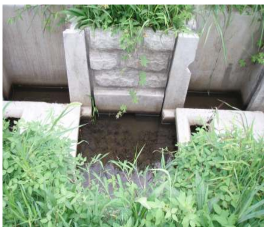
자연스러운 옆판 및 수질정화체 설치
