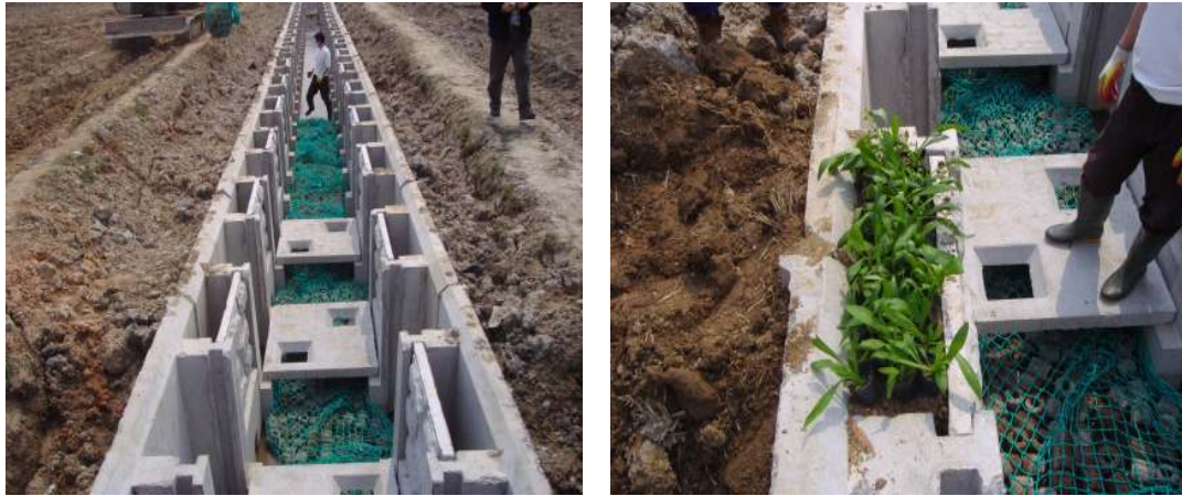
<그림 3.2.19> 수질정화체 설치 및 식재부 식재
