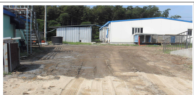
트렌치 작업 완료 후
