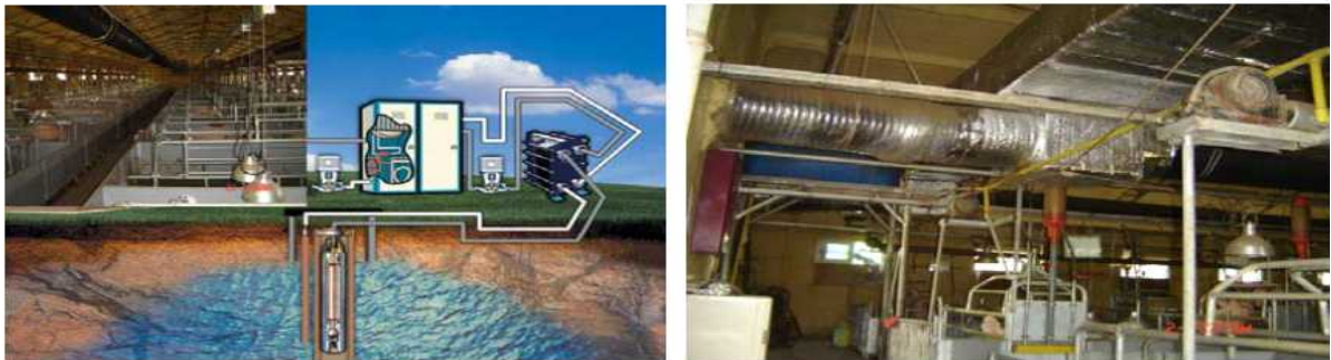
그림 1. 지열이용 축사 냉·난방 시스템
