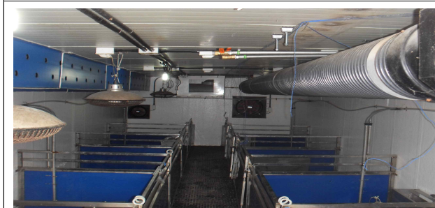
인큐베이터 내부 설치 전 모습
