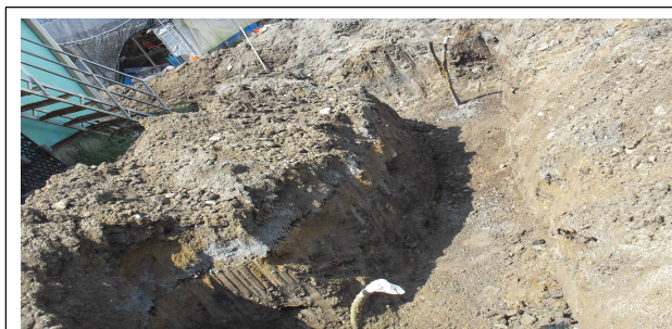
천공 후 트렌치 배관 작업 전
