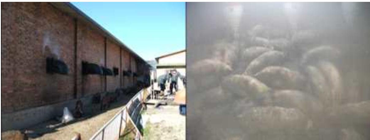
[그림 4] A 양돈장 외형 & 양돈장 내부 피트돈방 (1차년도 현장 양돈장의 실상도 , 2012~2013)
