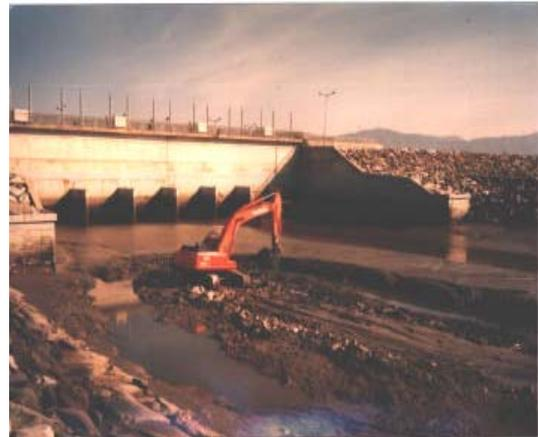
(그림 2-17) 백호를 이용한 퇴적토사 제거
