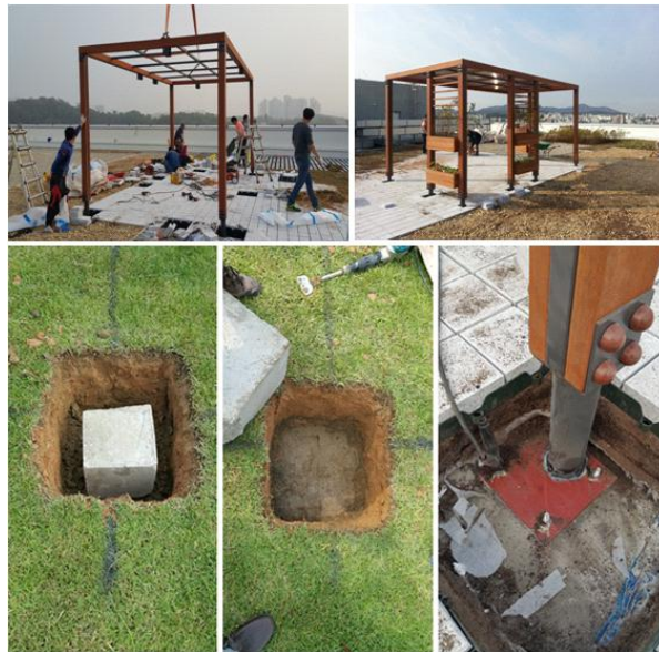
Fig. 166. 가든팜 파고라의 시공 사진
