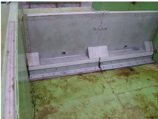
(A) 기능시험모형 2련 게이트 설치
