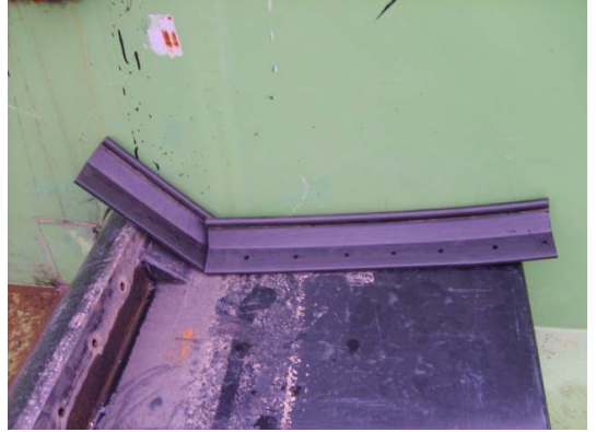
(F) LP형 지수고무 설치
