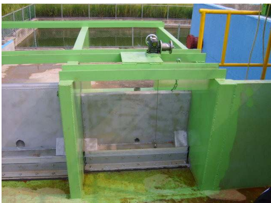
(C) 기능시험모형 비상 게이트 설치
