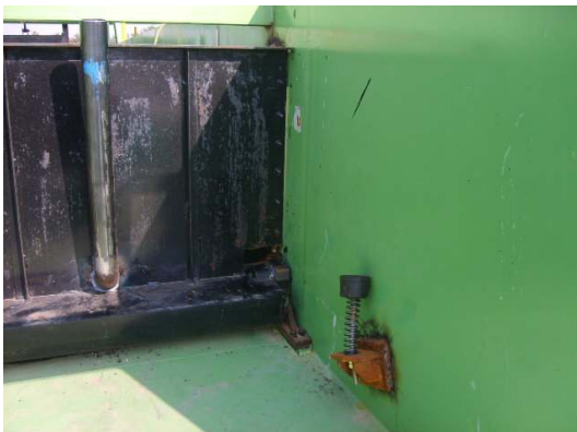
(C) 전도 스토퍼 설치
