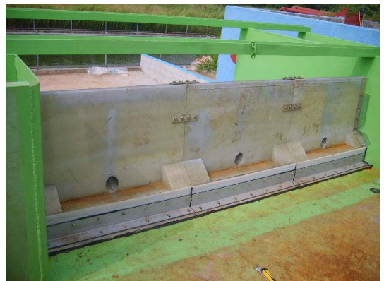
(B) 기능시험모형 3련 게이트 설치
