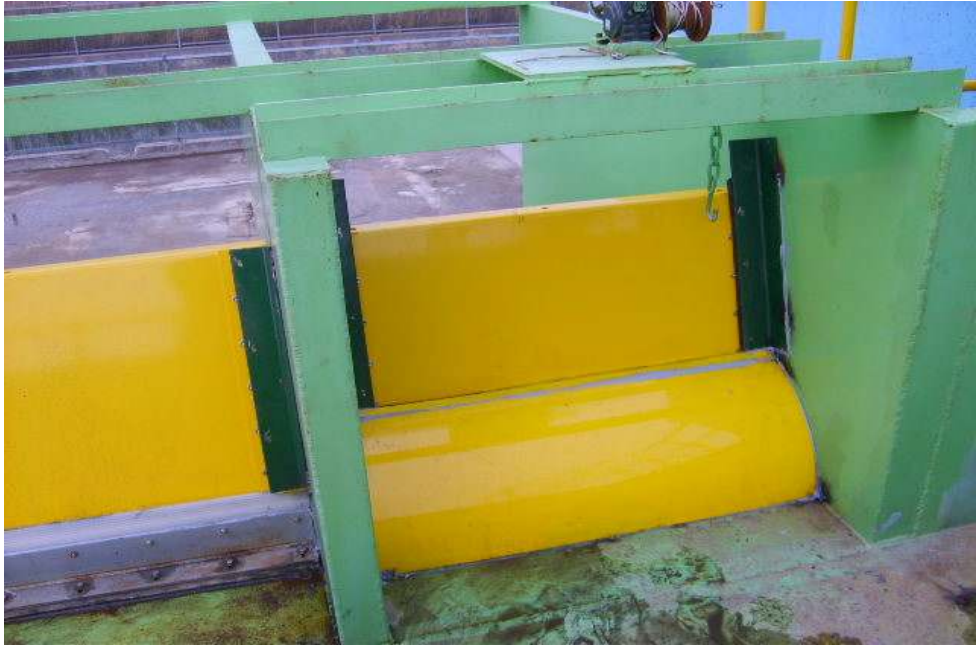
(D) 개량형 무동력 게이트 전면 보호캡 설치
