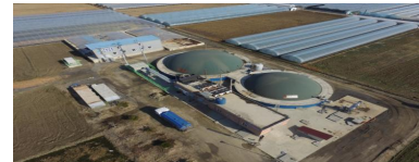
<칠성에너지 바이오가스 처리시설>
