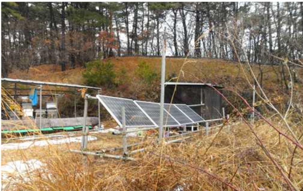
그림 40 경기양봉장에 독립전원을 위한 태양전기 발전, 저장시설 설치
