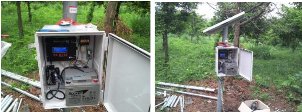
그림 37 외부 보호함 및 태양광 모듈 설치 모습
