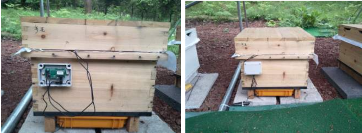
그림 35 센서노드 전원공급 케이블 견선 완료 모습
