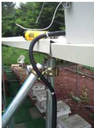
그림 33 센서노드 전원 공급 케이블 설치 모습 (케이블 보호를 위해 플렉시블관 설치 후 케이블 인입시킴)
