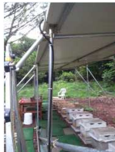
그림 33 센서노드 전원 공급 케이블 설치 모습 (케이블 보호를 위해 플렉시블관 설치 후 케이블 인입시킴)
