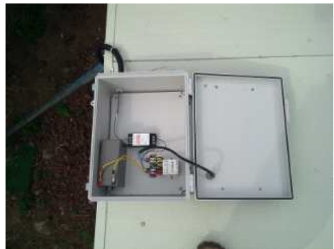
그림 56 외부보호함 설치
