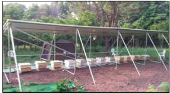
그림 11 제주대학 구내에 설치한 실험사육장. 40mm의 철제봉과 sandwich panel을 이용한 비가림 시설
