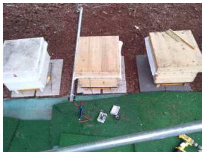
그림 34 센서노드 전원 공급 케이블 견선 작업 사진
