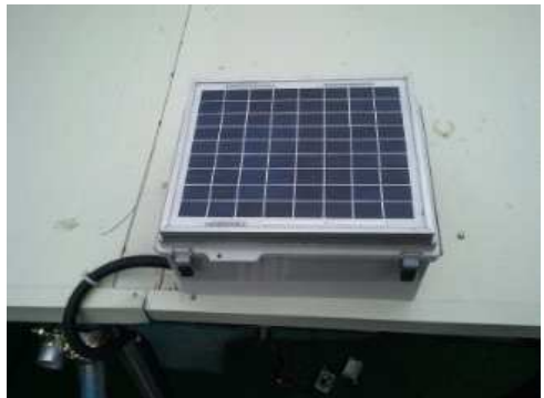
그림 57 태양광 모듈 설치
