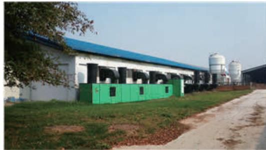
그림 36 돈사 외부에 미생물을 이용한 바이오필터 시설
