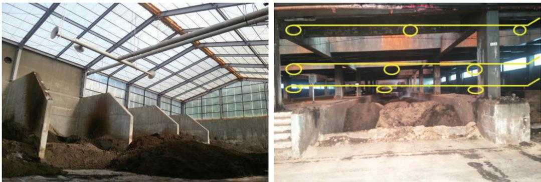
그림 76 넓은 퇴비사에서의 흡입 덕트 설치
