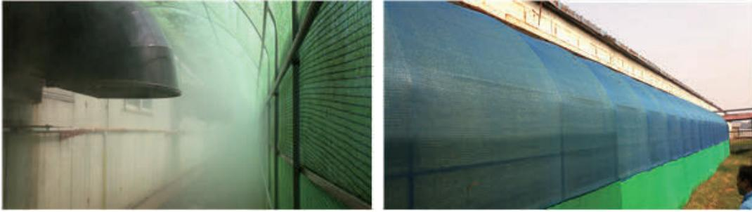
그림 35 방풍벽 및 분무노즐 설치
