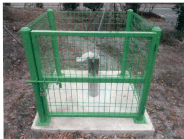
1) 관측공 굴착, 보호시설 설치
