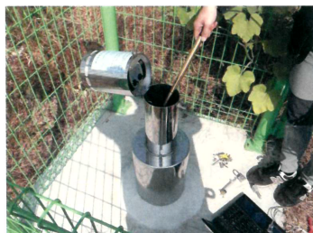
3) 관정내장형 관측장치 설치
