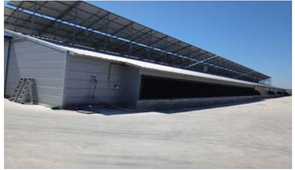
【사진 38】 무창오리사 전경
