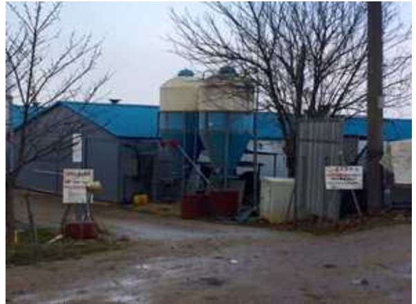
【사진 4】 출입문 미설치 예
