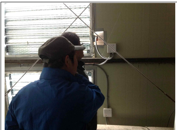
【사진 40】 계사 내 시설(입기장치) 점검
