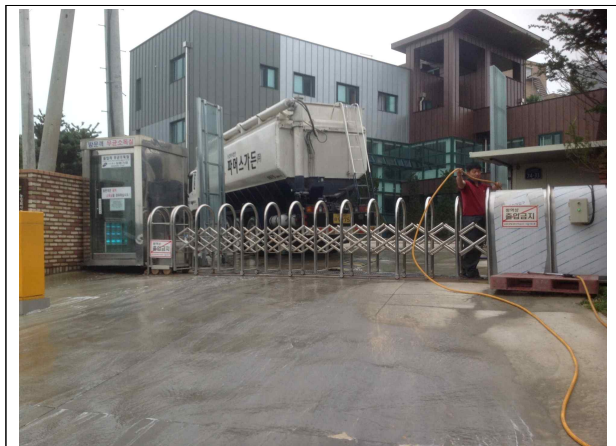
【사진 4】 차량진입 직후 출입문 잠금 유지
