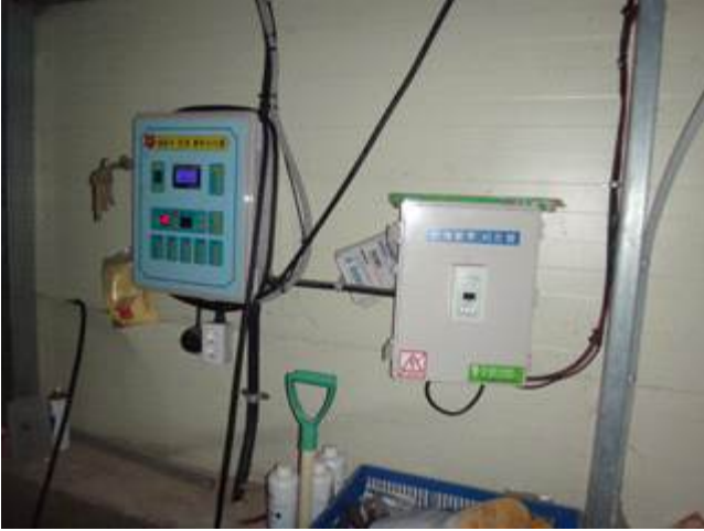
【사진 28】 오리사 내 분무소독 시스템
