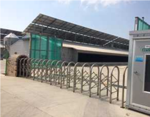
【사진 3】 출입문 잠금 유지
