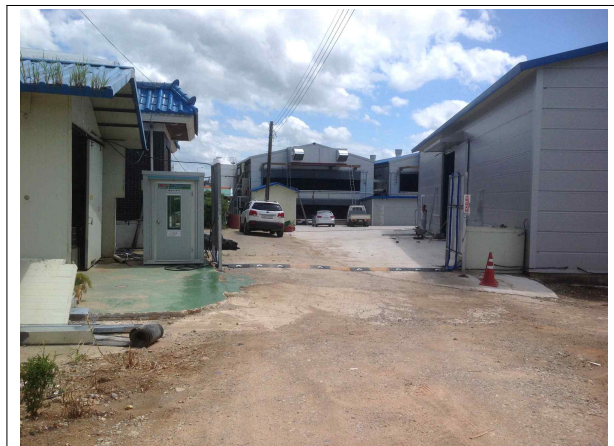
【사진 5】 출입문 미설치 예
