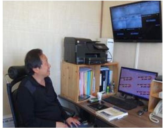
CCTV 설치 및 실시간 확인
