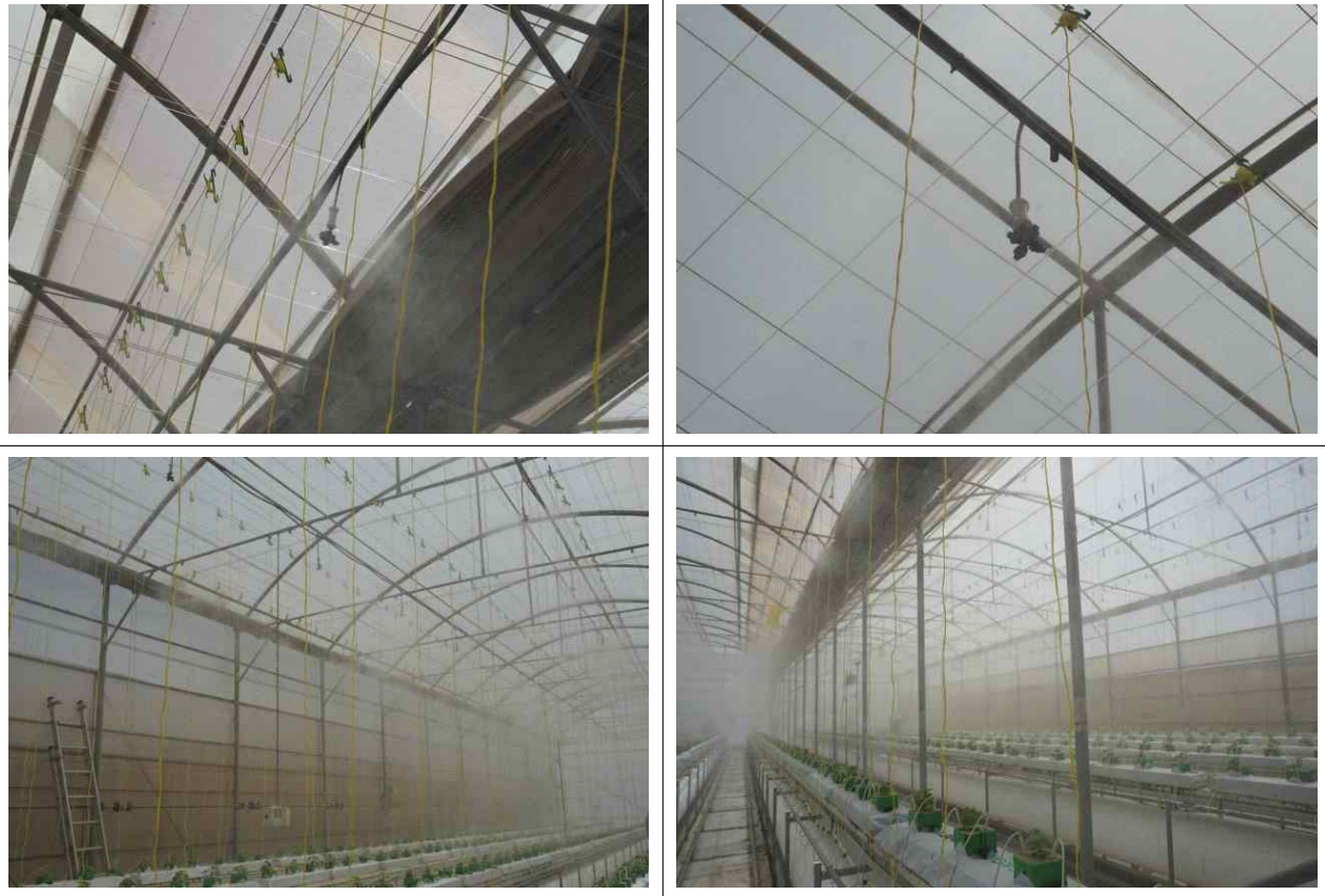
기존 스프링 쿨러 형식 포그 시스템
