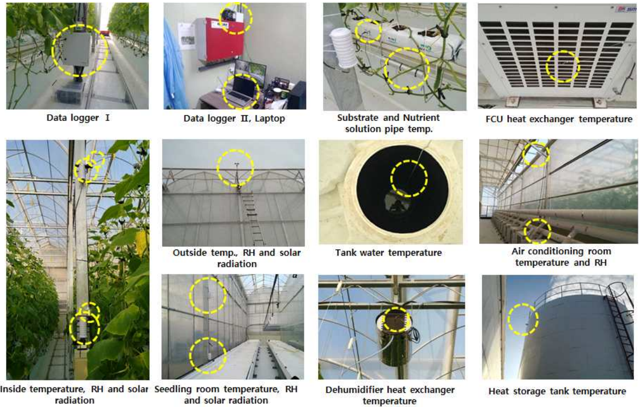
사막형 온실 냉방패키지 성능분석을 위한 센서 설치
