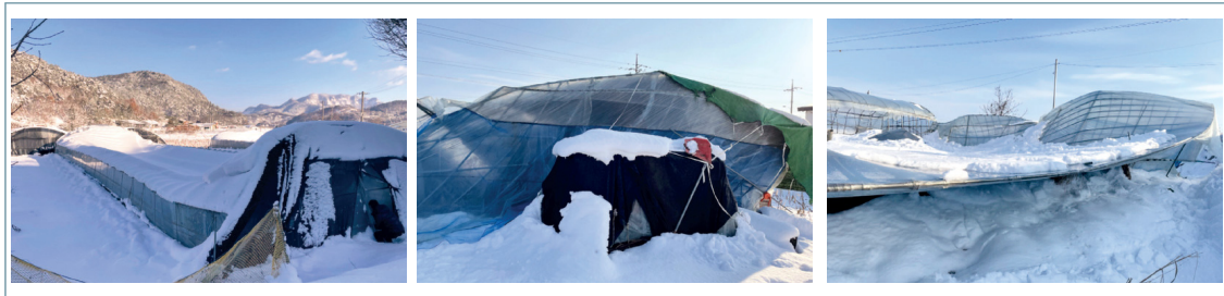
[그림 1-4-28] 대설·한파·강풍 피해 현황(비닐하우스 파손)
