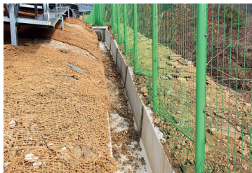
태양광 배수로 정비
