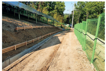
태양광 보완시공(통나무 얹기)
