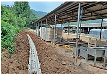
축사 배수로 정비
