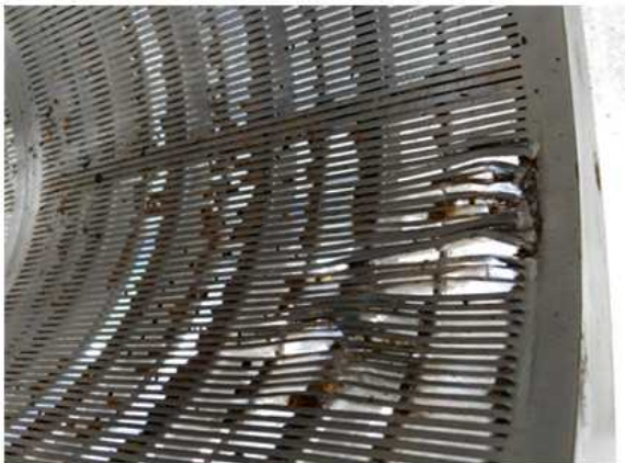
<시험평가 후 작은 이물질 투입되어 스크린 파손_내부상태>
