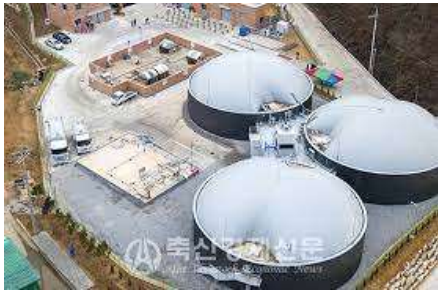
(c) 공동자원화 가축분뇨 바이오가스 시설
