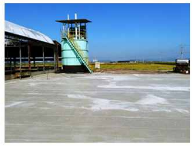
(c) 바닥공사 마무리 상태(콘크리트)
