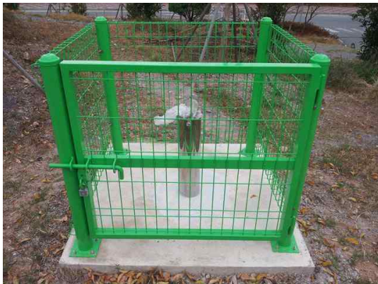
(a) 관측공 굴착, 기초, 보호시설 설치
