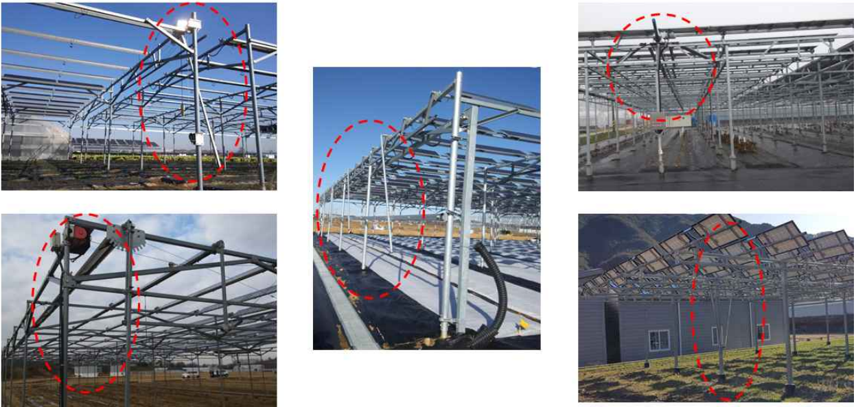
그림. 영농형 태양광 시스템의 모듈 각도 조절에 따른 상부구조 설치 사진
