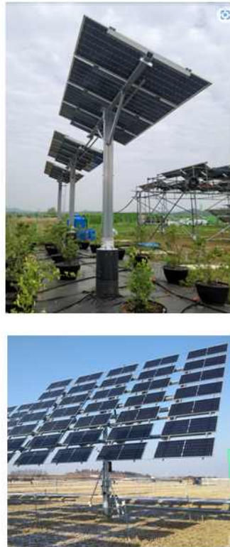
그림. 영농형 태양광 구조물 기둥 구조의 종류별 설치 사진
