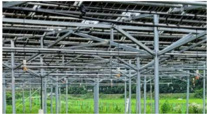
그림. 영농형 태양광 시스템 상부구조의 기능성 부품 설치 사진
