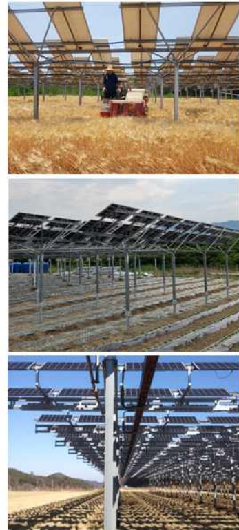
그림. 영농형 태양광 구조물 기둥 구조의 종류별 설치 사진
