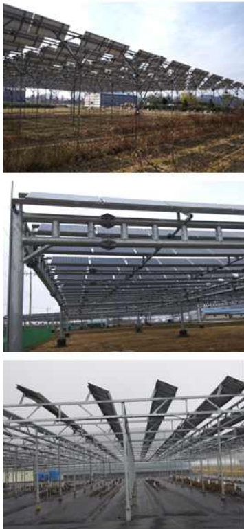
그림. 영농형 태양광 구조물 기둥 구조의 종류별 설치 사진
