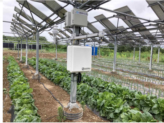
(a) 50 KW 단면형 영농형 태양광발전 시스템 (b) 설치된 RT1 일사량계
