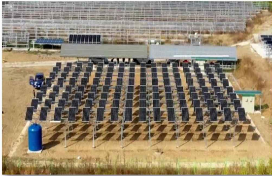
영농형태양광 구조물 (smart solar pipe) 설치 (2019. 11. 03)
