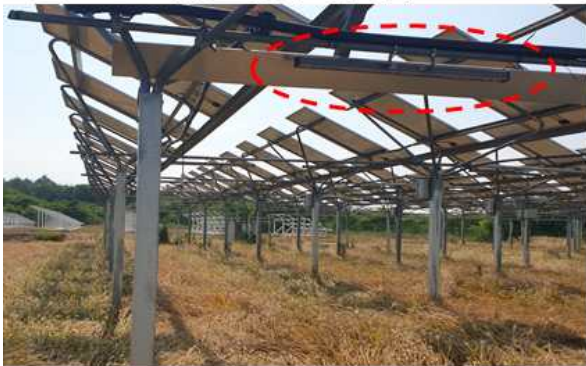
LED 보광시스템 설치
