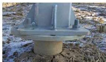
그림. 영농형 태양광 구조물 기초구조의 종류별 설치 사진
