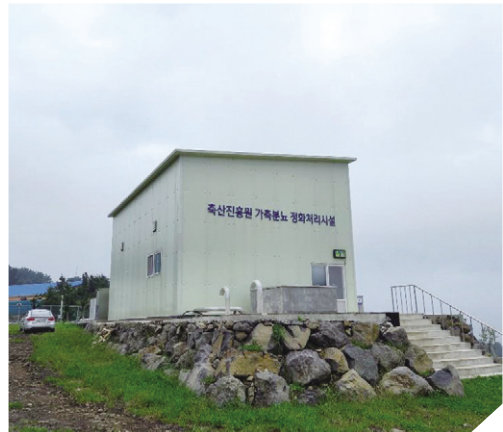
제주축산진흥원 기계실 전경
