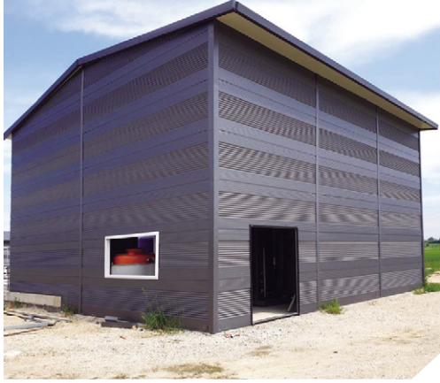
헤비팜 기계실 전경
