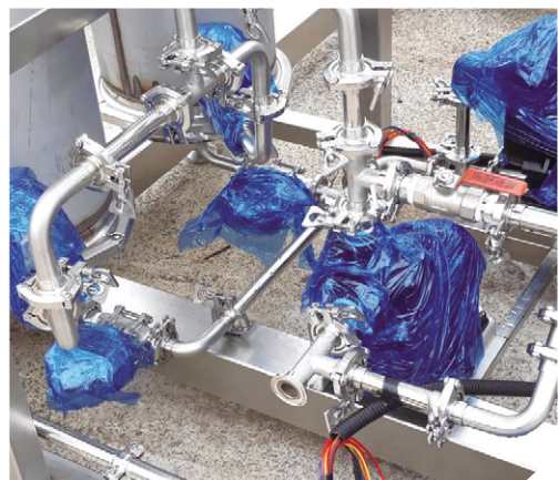
기계 배관 설치 사진
