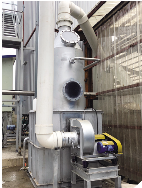
악취저감설비 설치 전경
