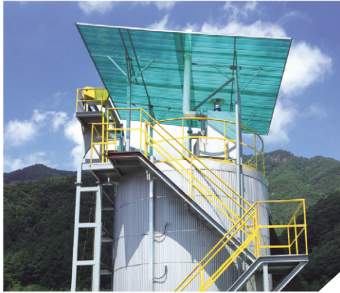
콤포스트 설치 전경
