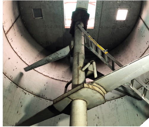
콤포스트 내부 교반날개 조립
