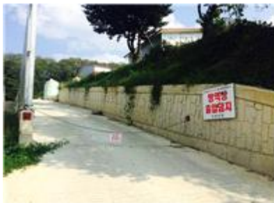
차단장벽 설치 및 경고판 부착 활용
