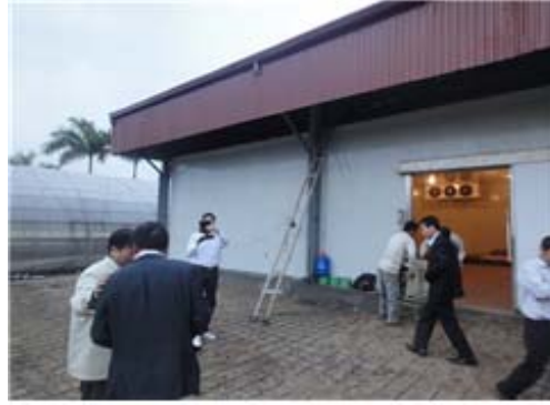
하노이대 감자저장고 신축 전경
