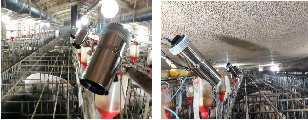
<사진. 조치원과 중원 SP 센터 현장에 설치된 포토니아>
