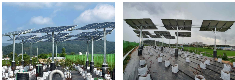
그림 117 16kW급의 블루베리 지주형 영농형 태양광 발전 시스템 전경
