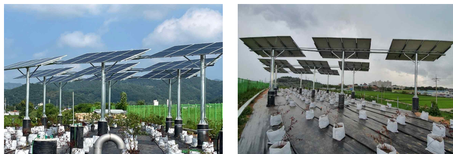
그림 225. 16kW급의 블루베리 지주형 영농형 태양광 발전 시스템 전경
