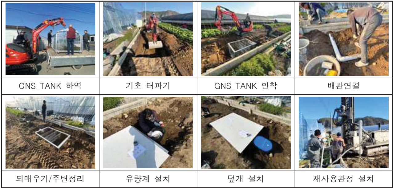
그림 3-22. 파일럿규모 저영향개발(LID) 시설 설치
