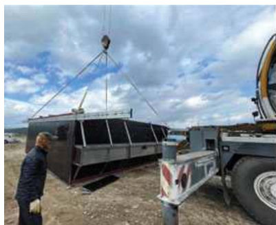
구조물 설치(크레인 연결)
