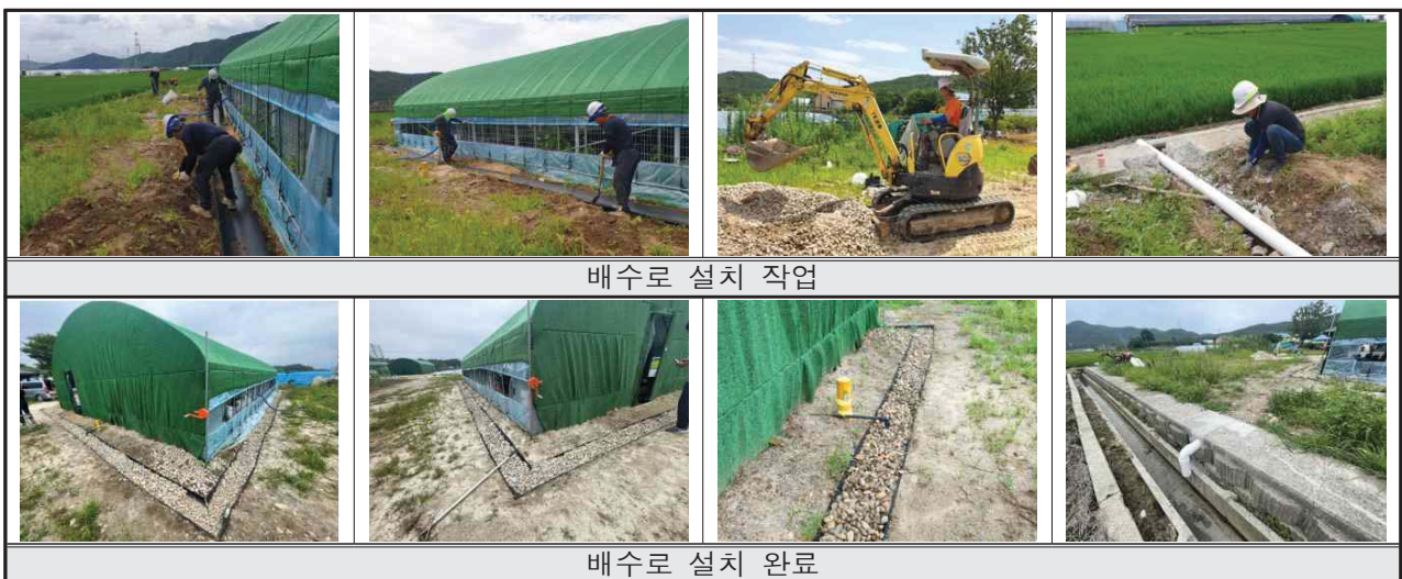
그림 6-14. 배수로 설치
