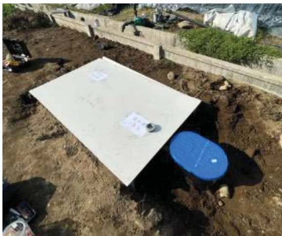
<북방지구 단동형 농어촌형 저영향개발 설치>
