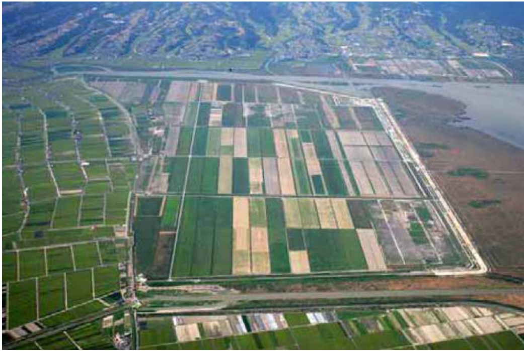
<Fig. 3-103> 이사하야만 간척지 전경
