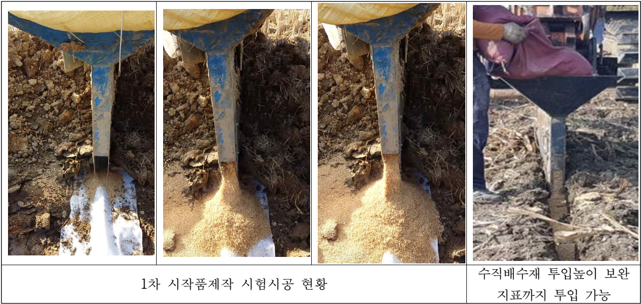
<Fig. 3-30> 유공관+수평매트+수직소수재 압거 시험시공 상황
