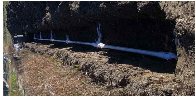
(f) 흡수암거 시공
