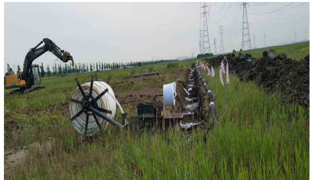
(d) 유공관+복합포 흡수암거 시공
