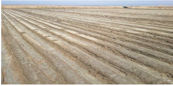
(a) 시공전 전경
