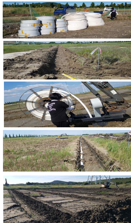
<Fig. 3-22> 지하관수 저류시트형 공법 시공순서
